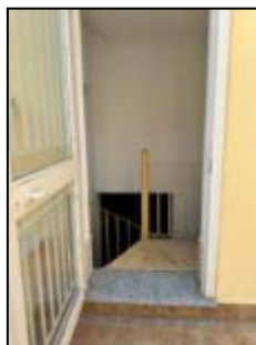
Scala accesso deposito 2
