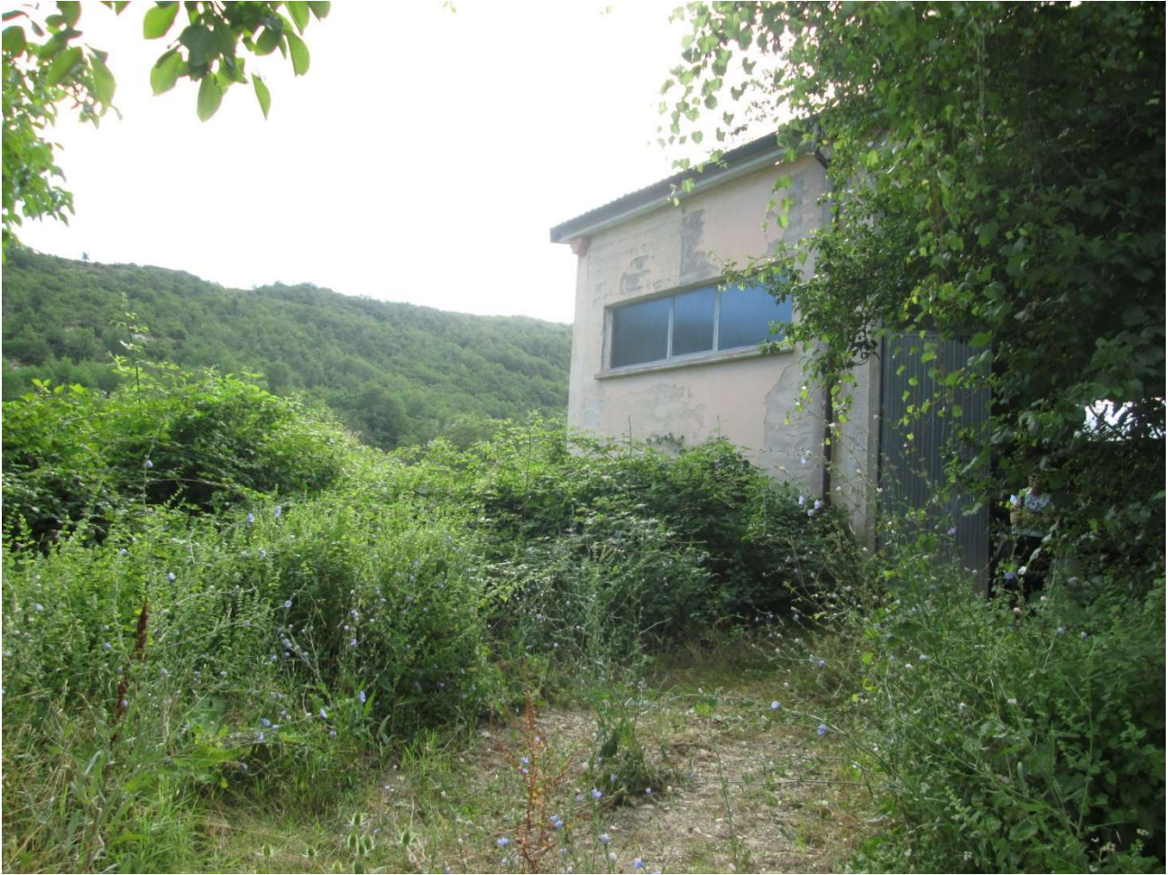
Scatto su parte del prospetto con porta d'ingresso e termine della stradina d'accesso.
