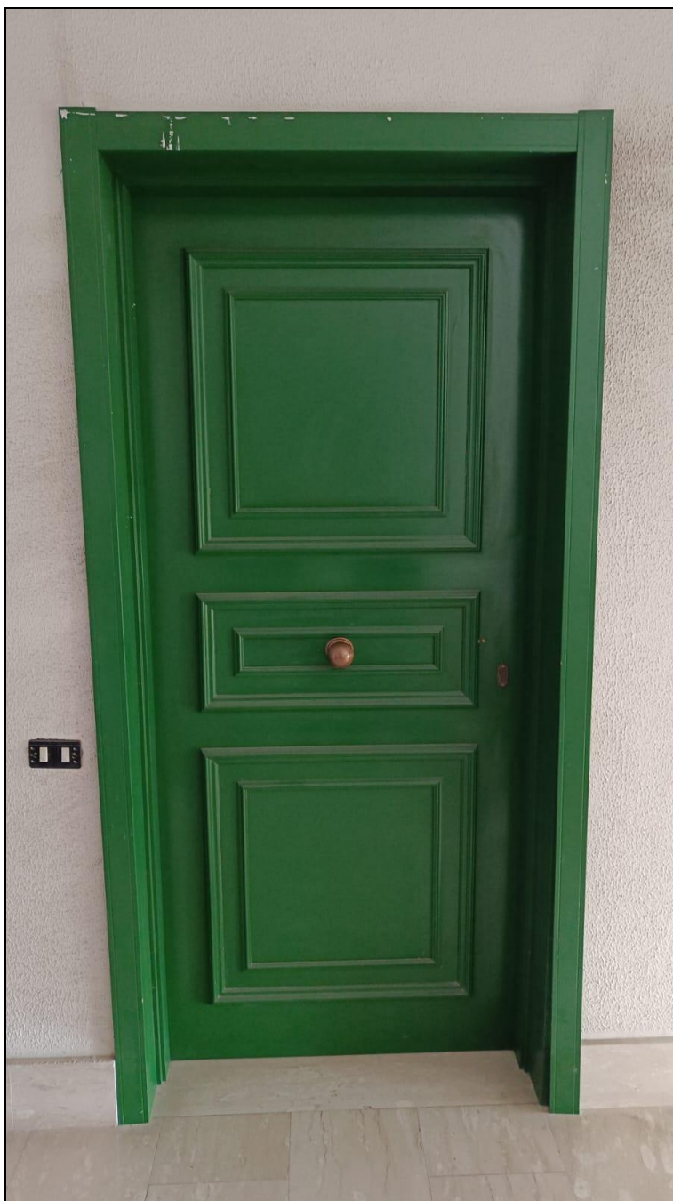
Ingresso del deposito identificato al sub 68, oggetto di stima
