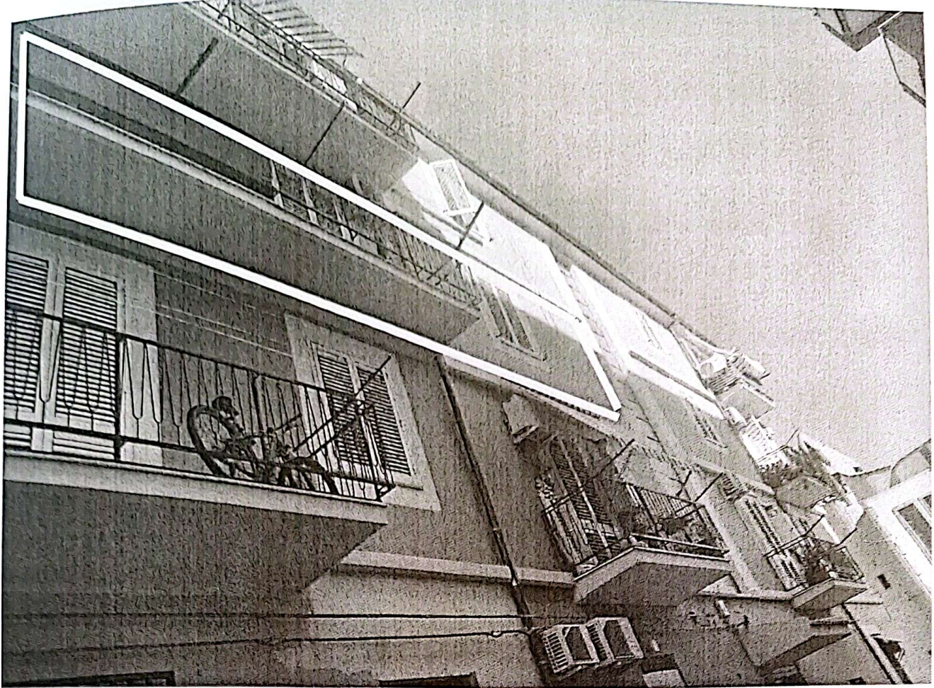
foto n.1 e 2 : Prospetto Abitazione vicolo Santa Lucia 5 piano secondo
