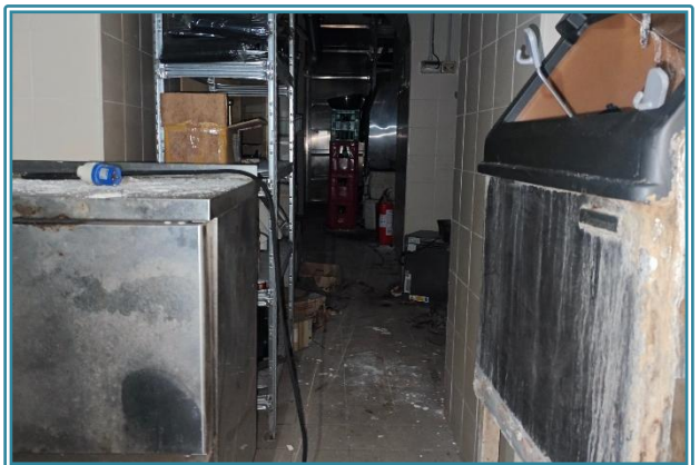
Figura 43 Locale Lavorazione – Piano Interrato
