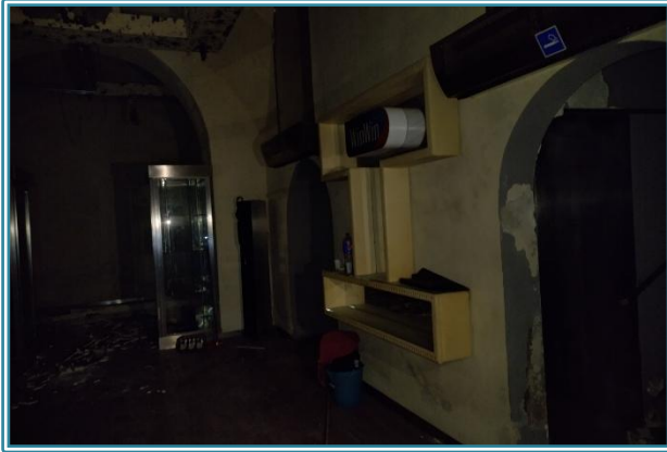
Figura 32 Sala2 – Piano Interrato
