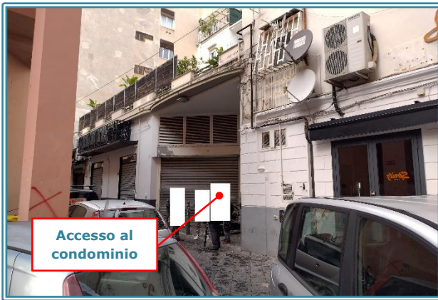
Figura 8 Vista fabbricato da Vico dei Sospiri
