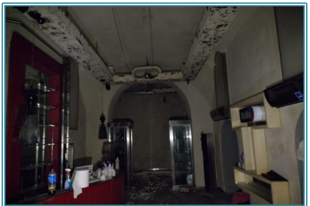
Figura 31 Sala 2 – Piano Interrato
