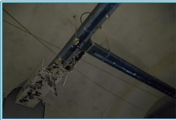
Figura 36 Particolare soffitto a volta – Piano Interrato
