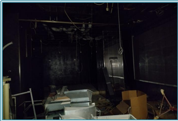
Figura 16 Sala1 - Piano Terra
