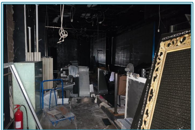
Figura 19 Sala1 – Piano Terra
