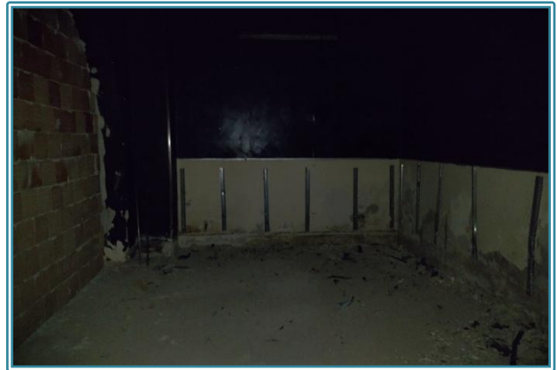
Figura 23 Locale1 – Piano Terra
