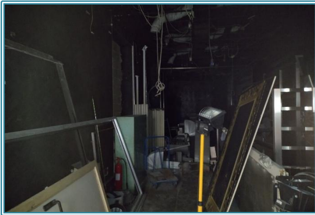
Figura 20 Sala1 – Piano Terra
