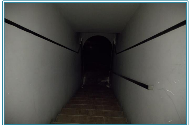
Figura 29 Scala di accesso al piano interrato
