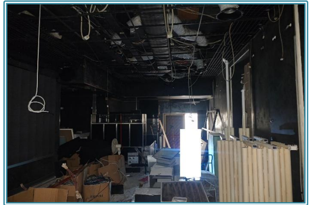
Figura 21 Sala1 – Piano Terra
