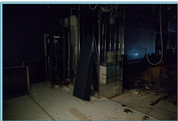
Figura 18 Sala1 – Piano Terra
