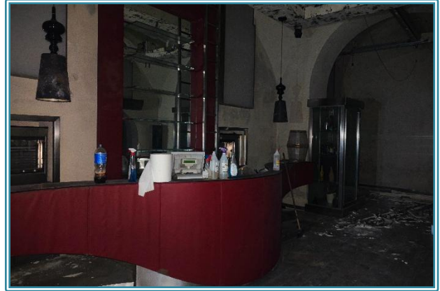
Figura 33 Sala2 – Piano Interrato
