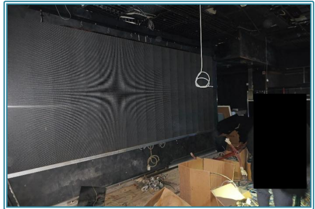
Figura 17 Sala1 – Piano Terra
