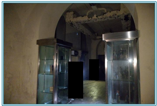
Figura 35 Sala3 – Piano Interrato
