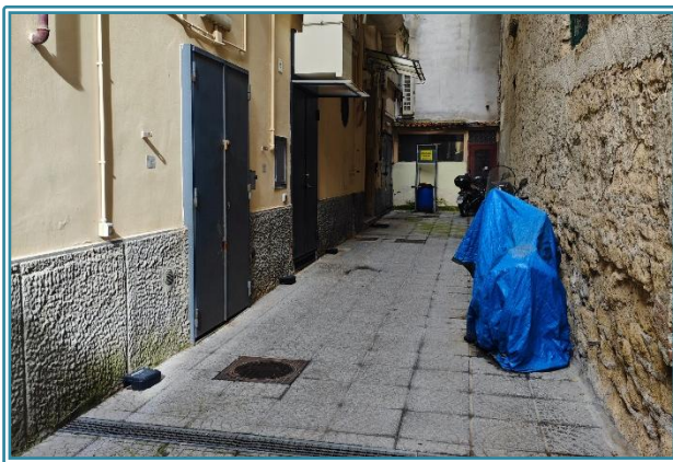
Figura 10 Cortile condominiale (particella 246)
