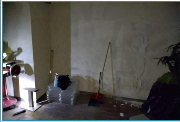
Figura 38 Sala4 – Piano Interrato
