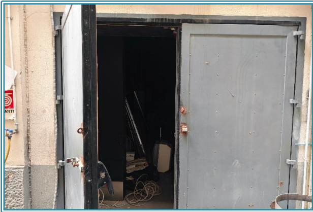
Figura 14 Ingresso al locale oggetto di pignoramento
