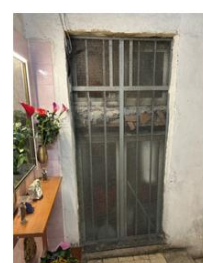
Foto 14 - Finestra del ospite pignonato che prospetta sul vano scala
