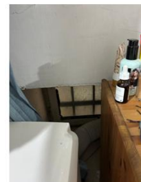
Foto 47 - Ambiente 2 su soppalco
