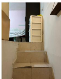
Foto 35 - Scala di accesso al soppalco
