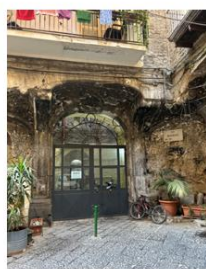
Foto 2 - Fabbricato in cui è ubicato l'immobile pignorato - ingresso
