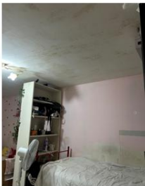
Foto 37 - Ambiente 1 su soppalco
