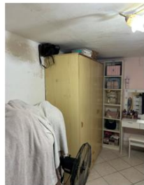
Foto 39 - Ambiente 1 su soppalco
