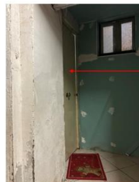
Foto 11 - Disimpegno comune d'accesso all'immobile pignonato - ingresso al ospite
