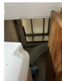
Foto 48 - Ambiente 2 su soppalco
