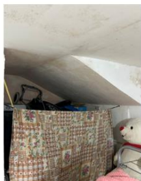
Foto 45 - Ambiente 2 su soppalco
