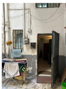
Foto 7 - Accesso all'immobile pignonato dal cortile
