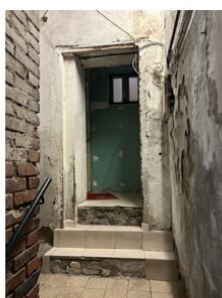
Foto 53 - Vaso scale - vano di disimpegno comune d'accesso all'immobile pignorato sub 78
