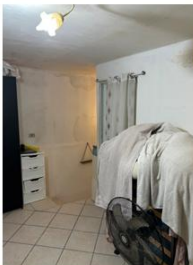
Foto 41 - Ambiente 1 su soppalco
