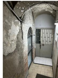
Foto 6 - Vano scala di accesso all'immobile pignorato
