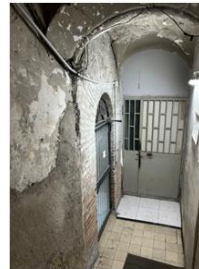
Foto 6 - Vano scala di accesso all'immobile pignonato
