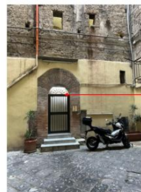
Foto 5 - Fabbicato in cui è ubicato l'immobile pignonato - ingresso al vano scala che conduce all'immobile pignonato
