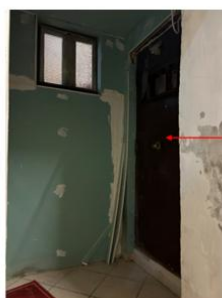
Foto 54 - Disimpegno comune d'accesso all'immobile pignorato sub 78 - ingresso al cespite
