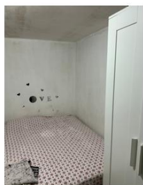
Foto 44 - Ambiente 2 su soppalco
