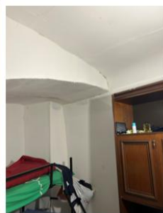
Foto 67 - SUB 78 - Ambiente n.2
