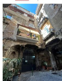
Foto 1 - Fabbicato in cui è ubicato l'immobile pignonato
