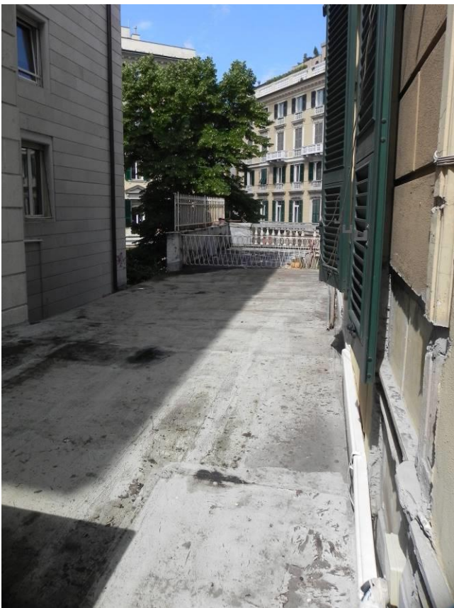
Foto 67 – Vista del balconcino in corrispondenza della Cucina
