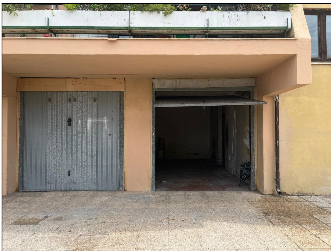
Ingresso esterno del garage identificato al sub 36, oggetto di stima
