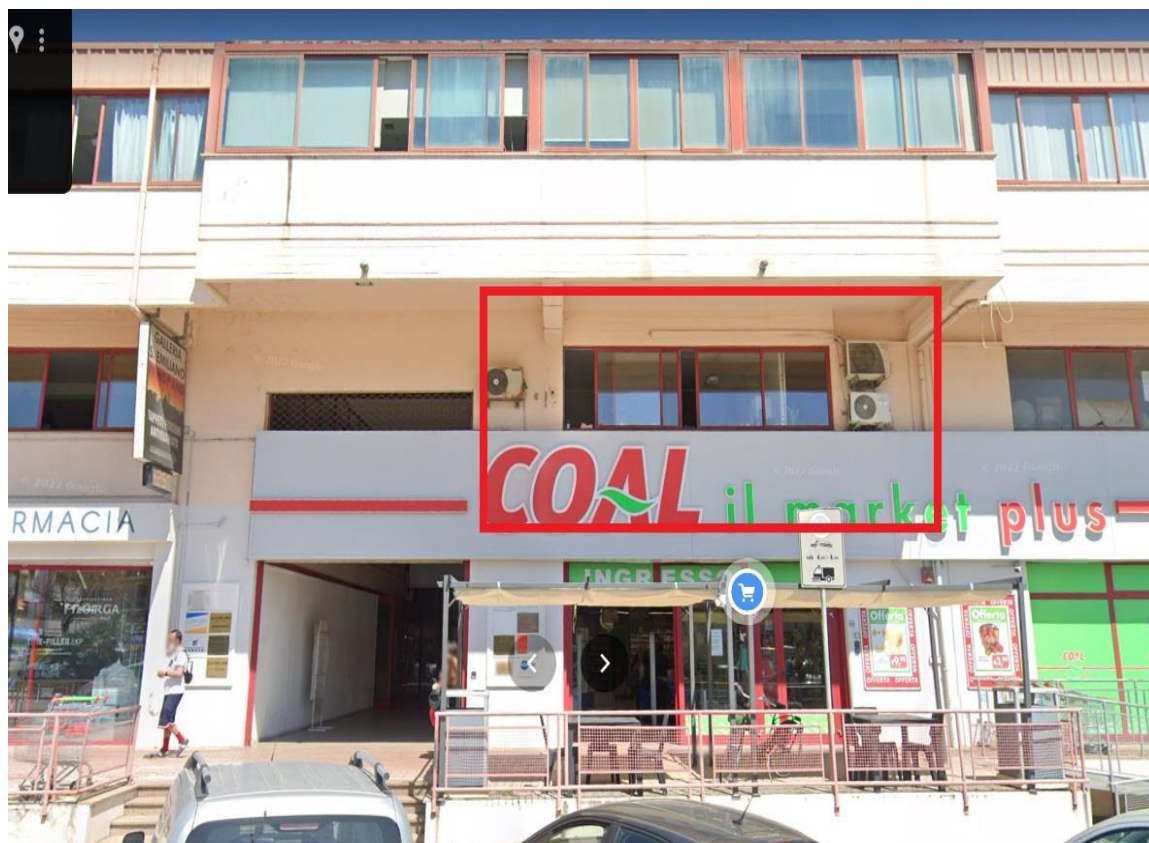
Foto n. 5: Prospetto sud con individuazione unità immobiliare
