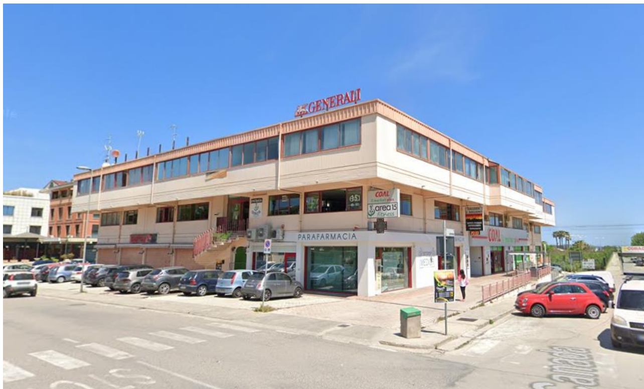
Foto n. 3: Fabbricato pluriuso prospetto sud-ovest
