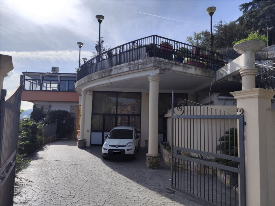
Foto 5 il sub 34 invaso parzialmente dal volume abusivo del sub 28
