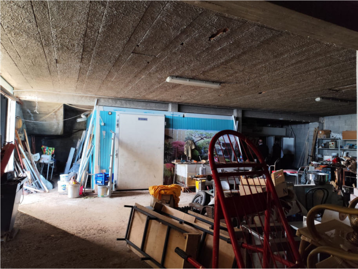
Foto 11 interno autorimessa sub 33 con cella frigo
