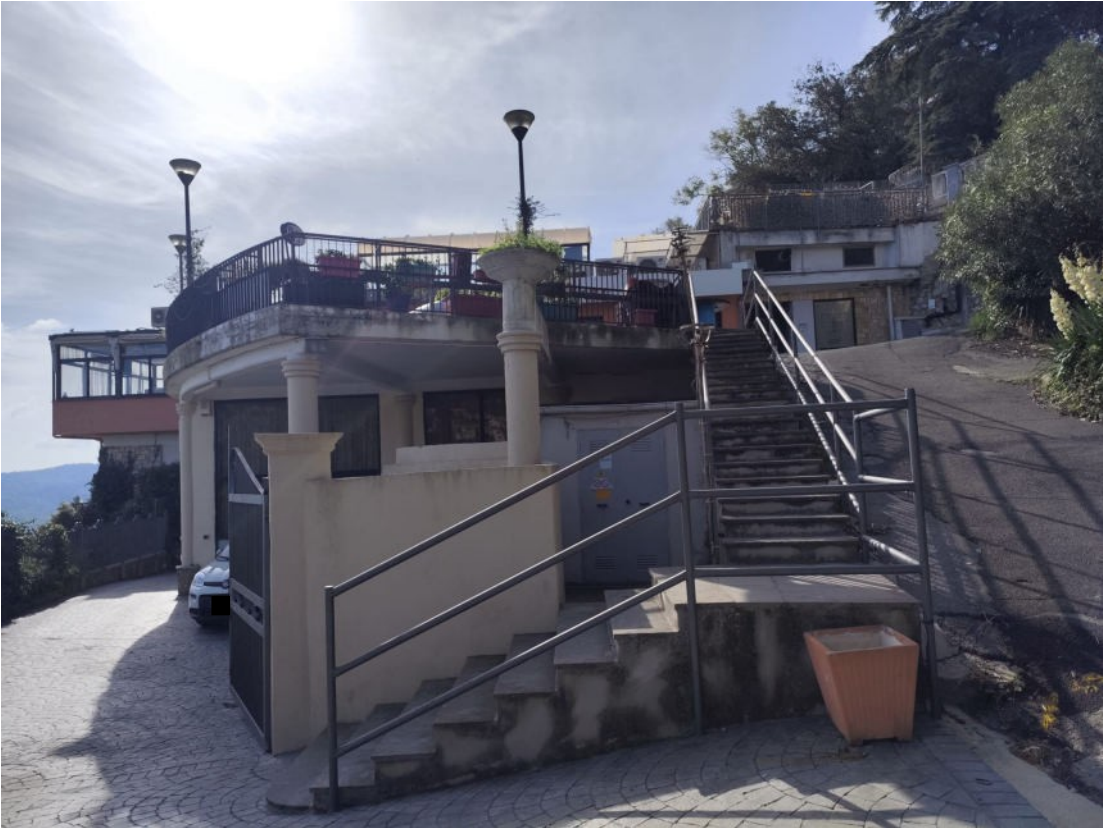
Foto 1 ingresso ristorante con in primo piano la canina elettrica e il posto auto coperto del sub 34
