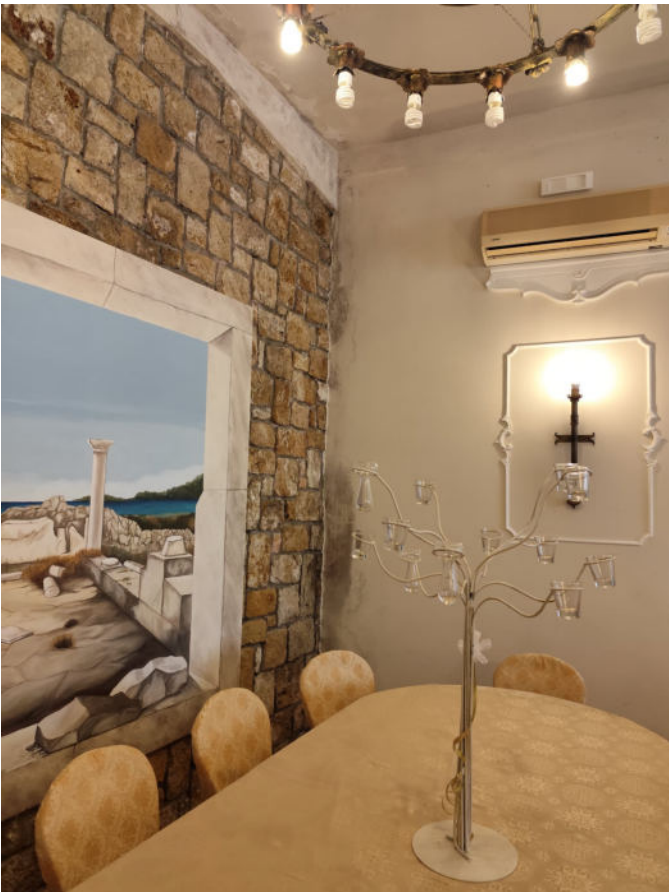
Foto 10 dettaglio infiltrazioni nell'espansione abusiva al sub 28
