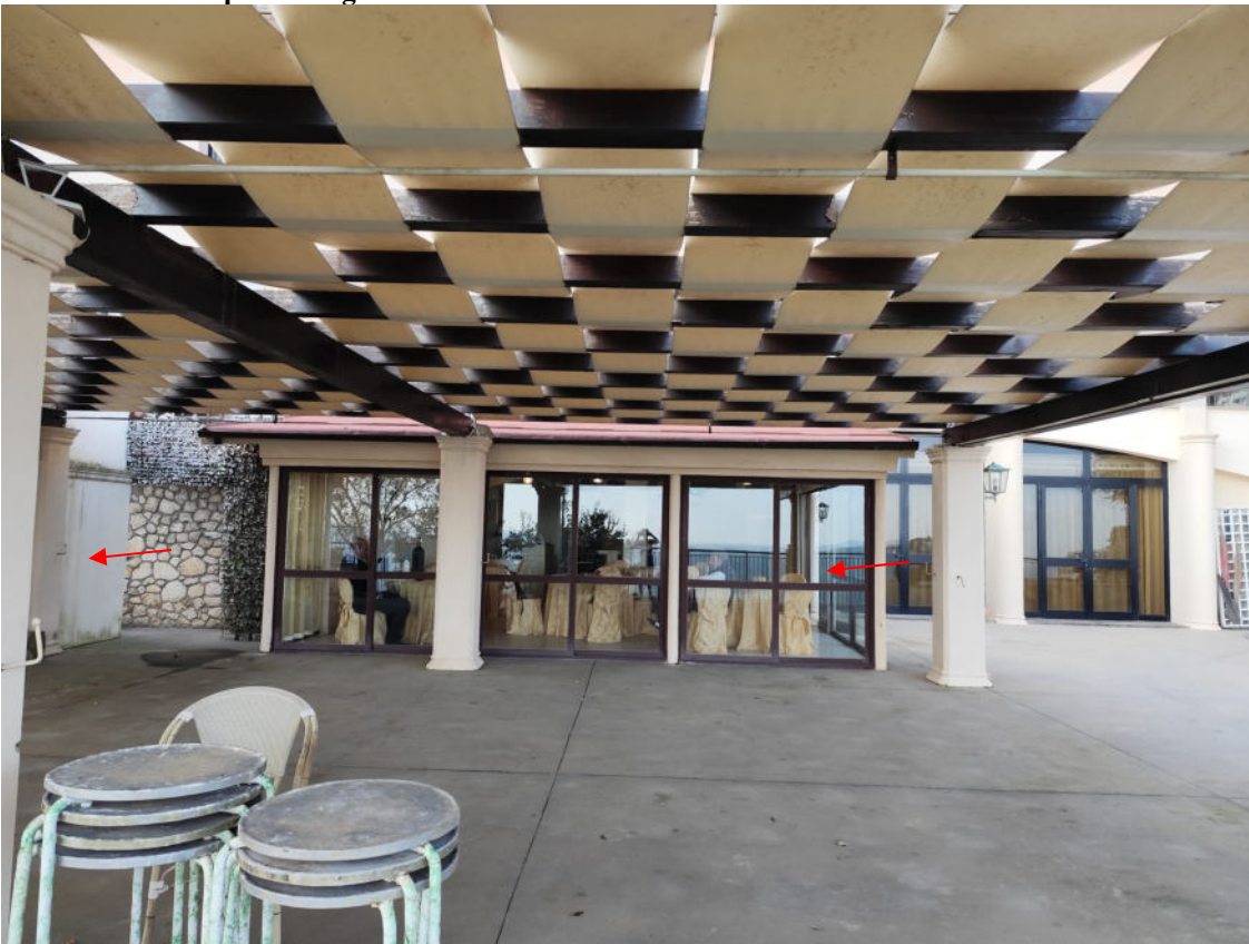
Foto 4 il volume abusivo della vetrata e a sin setti per schermare i cassonetti
