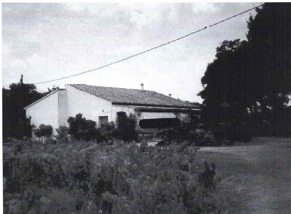
Fabbricato 2.a - Esterno
