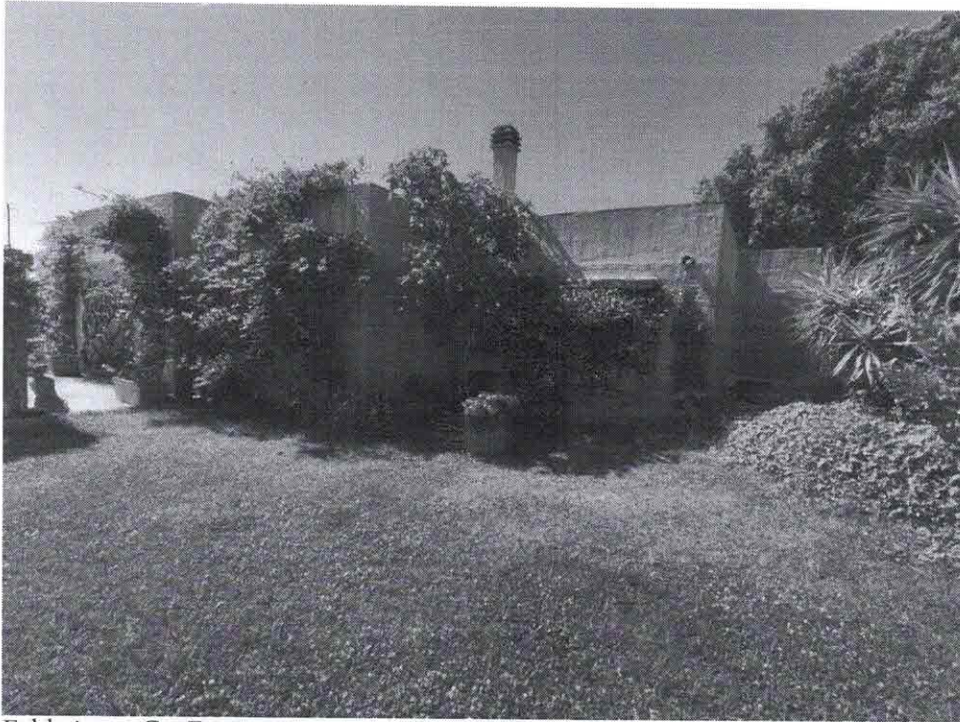
Fabbricato G - Esterno
