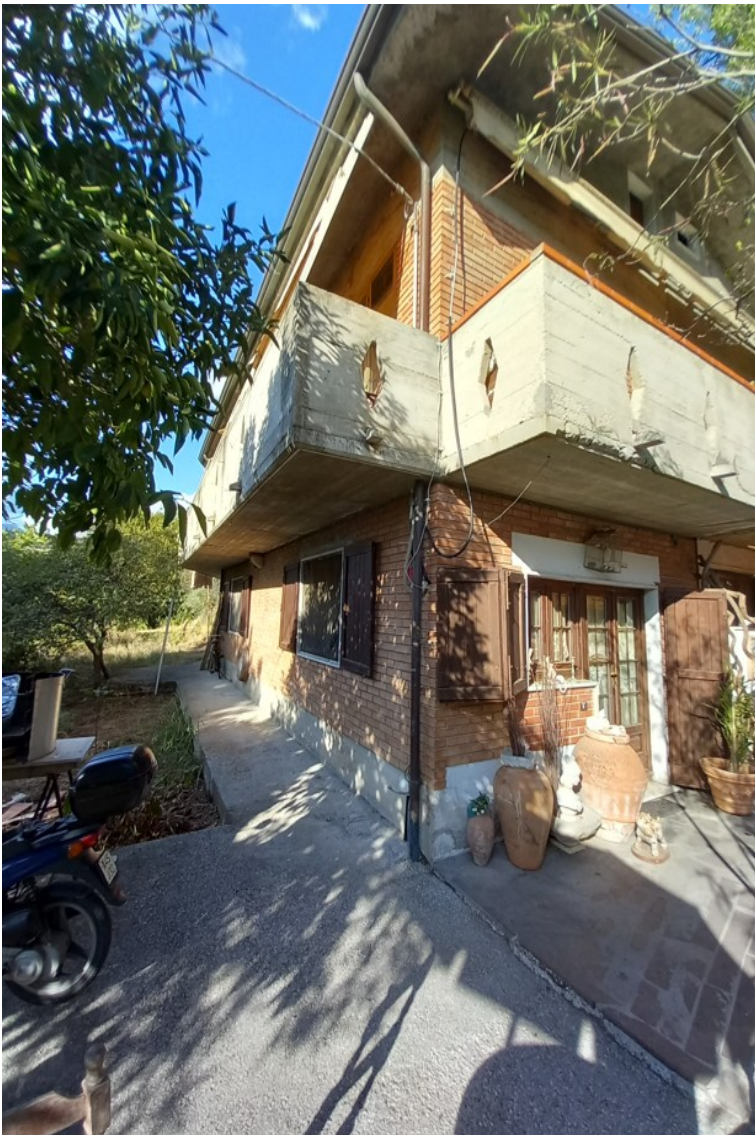
FOTO N°20: FABBRICATO A : prospetto ovest
