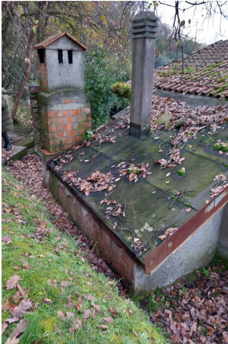
FOTO N°23: FABBRICATO A: porzione prospetto est _ particolare forno
