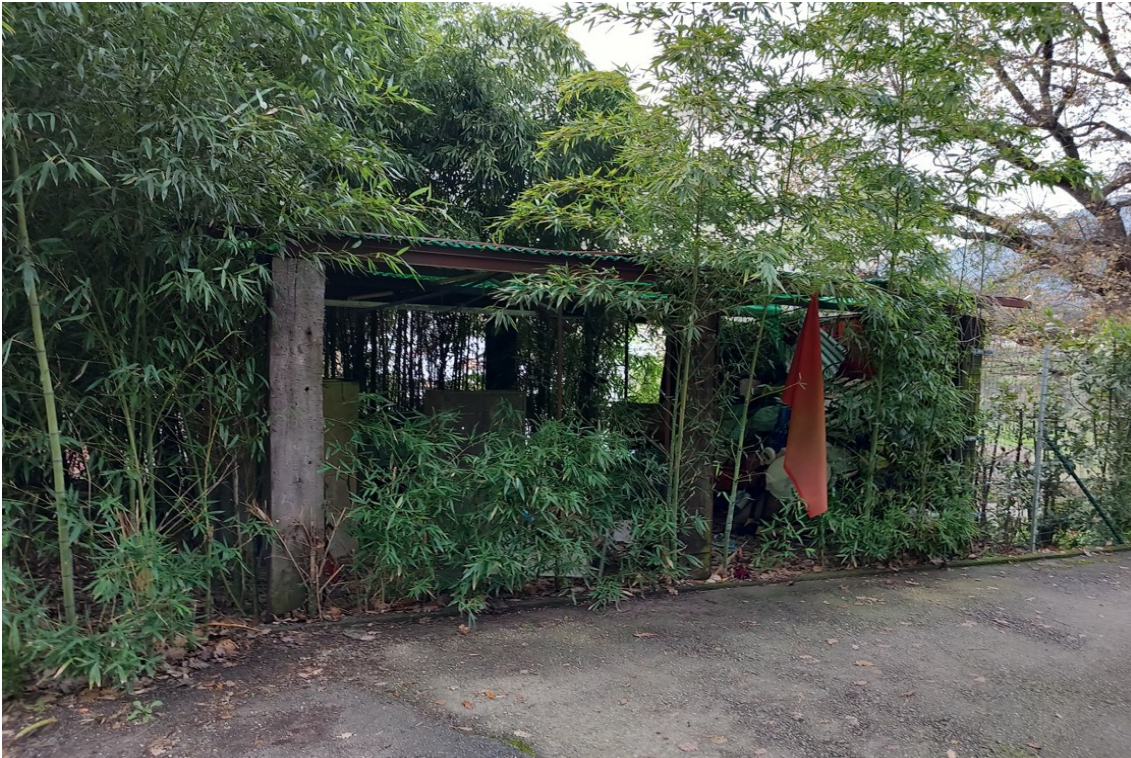
FOTO N°31: FABBRICATO F: tettoia
