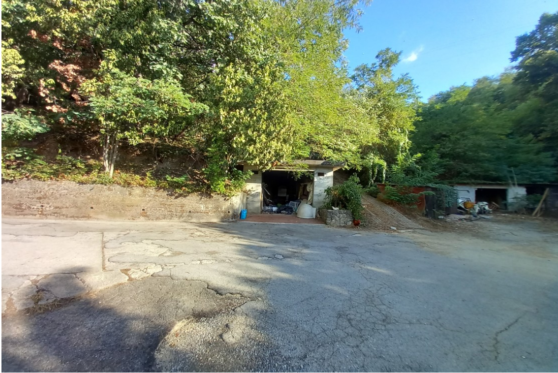
FOTO N°29: FABBRICATO D: manufatto ad uso garage
