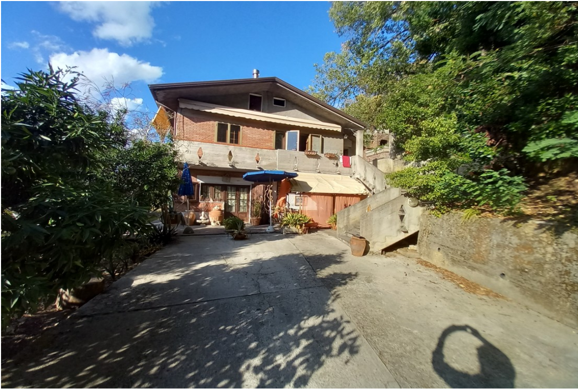
FOTO N°19: FABBRICATO A : prospetto sud
