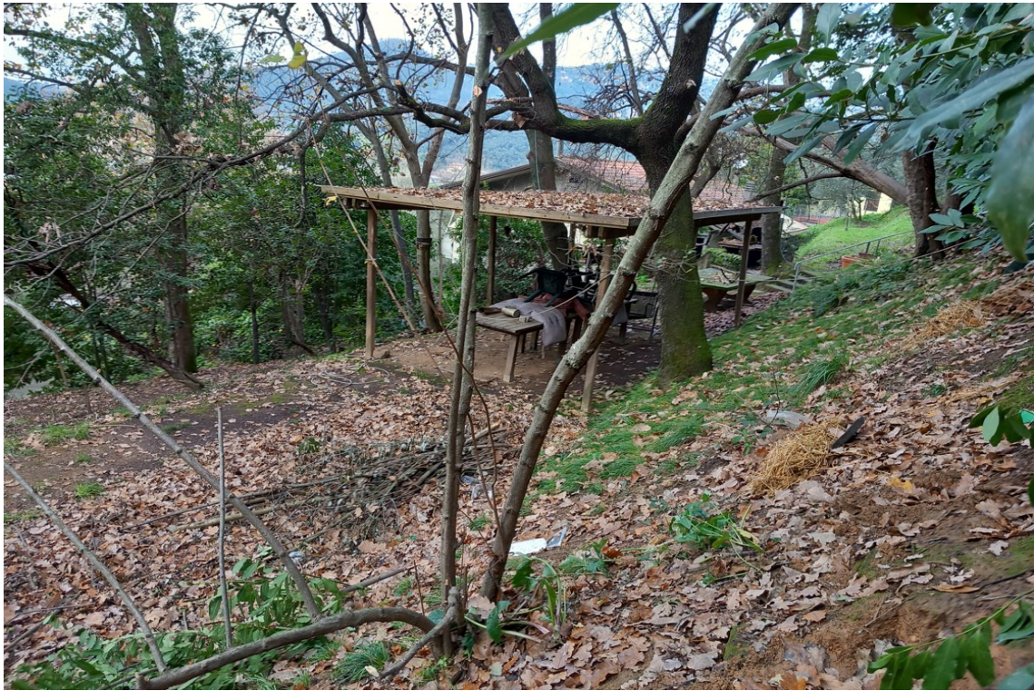
FOTO N°27: FABBRICATO C: pergolato coperto
