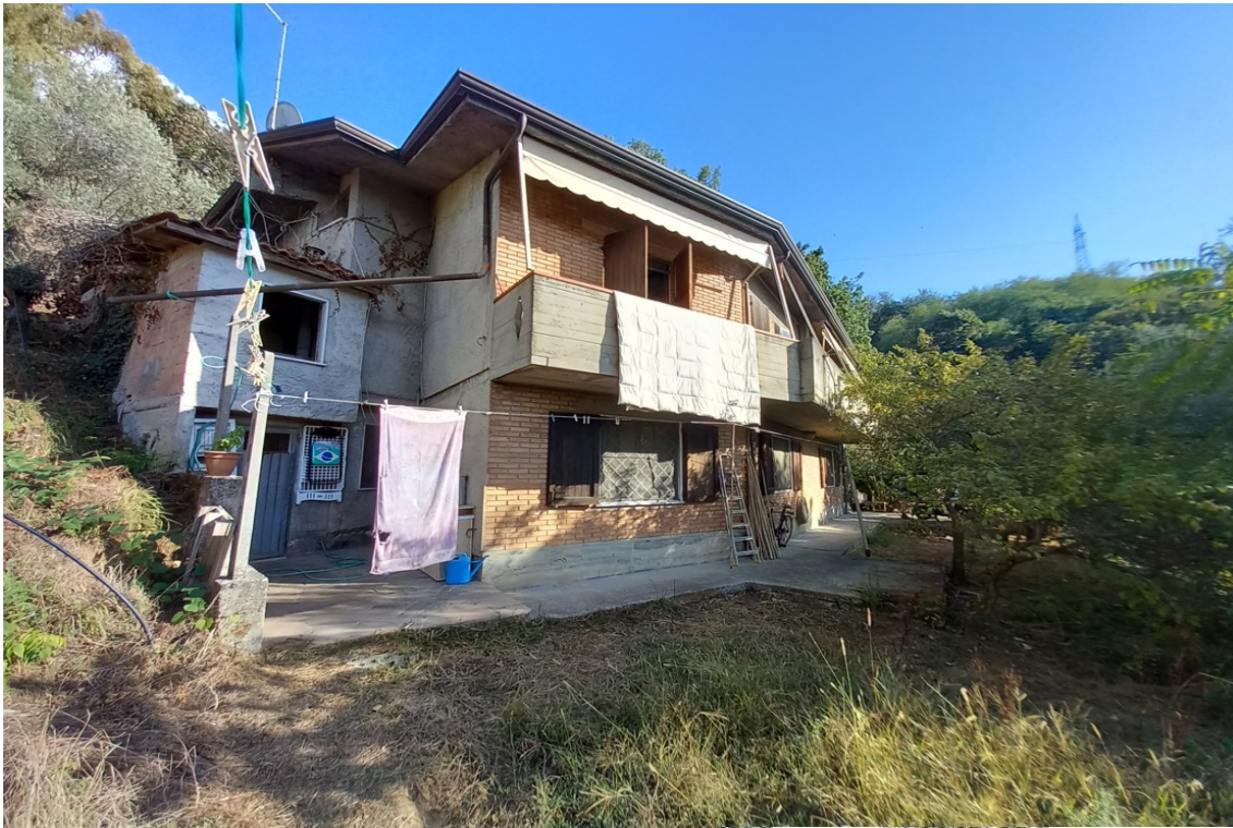
FOTO N°21: FABBRICATO A : prospetto ovest e porzione del prospetto nord
