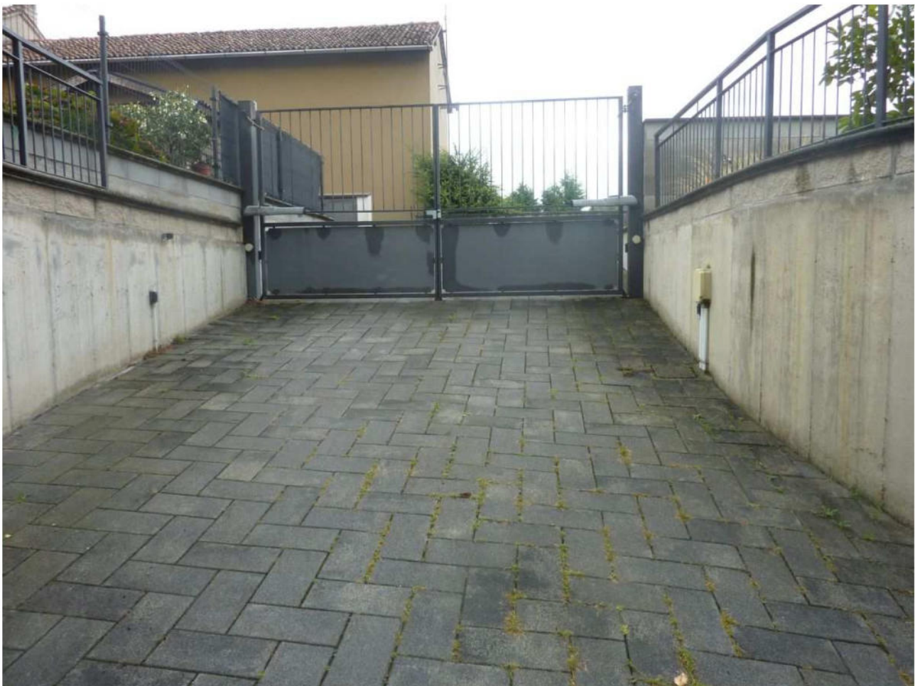
23. Rampa di accesso alle autorimesse del piano interrato
