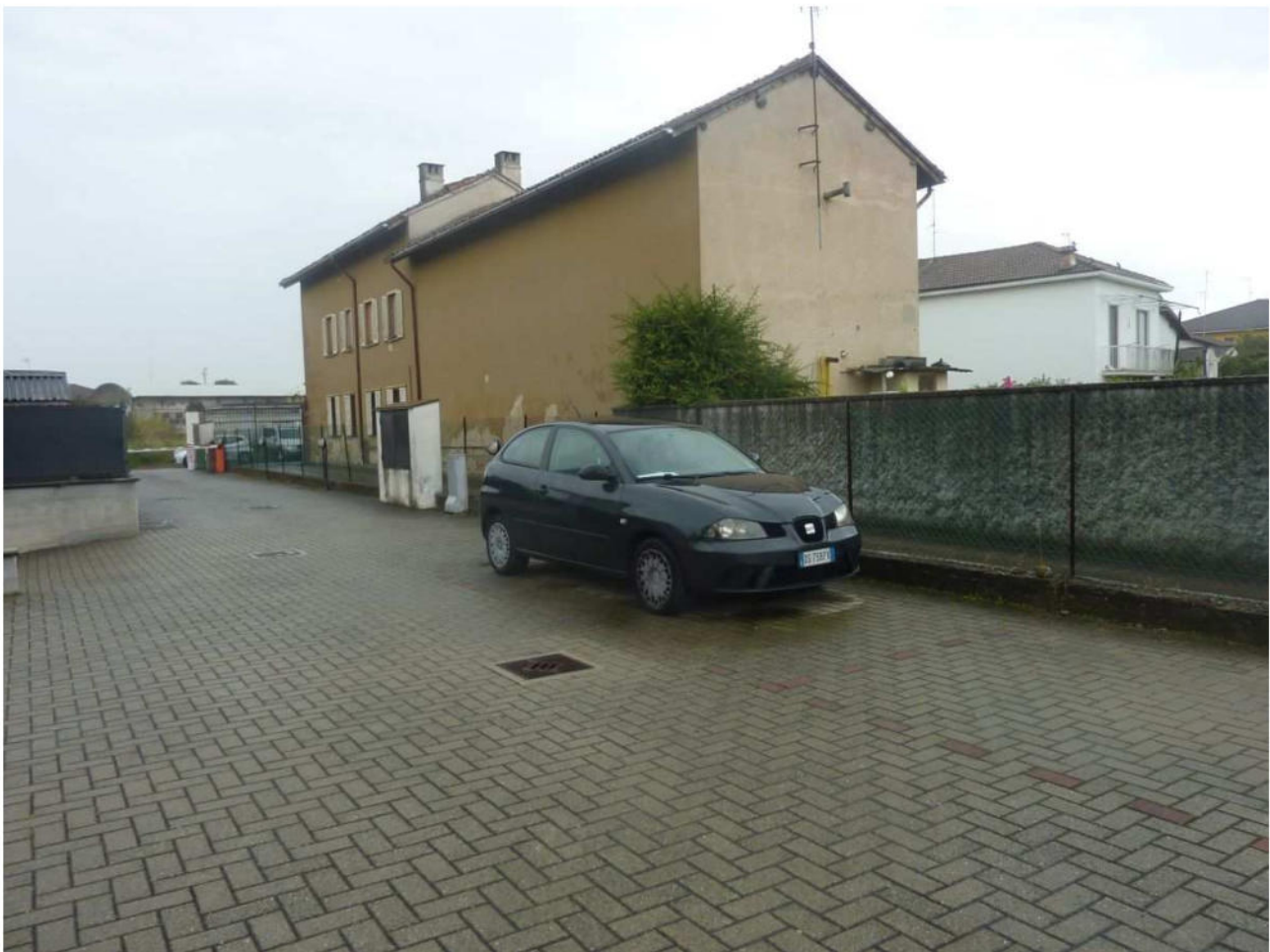
27. Area del posto auto di proprietà esclusiva nel cortile condominiale
