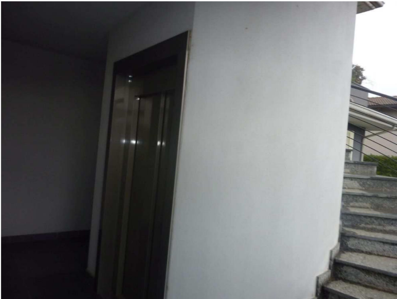
6. Vano ascensore al piano terra
