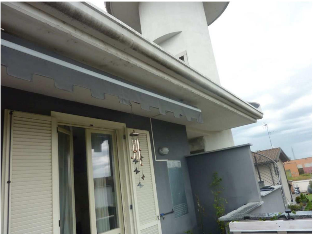
19. Gronda a parziale copertura del terrazzo
