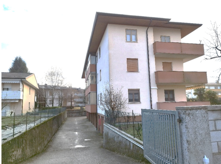
Particolare prospetto fabbricato condominiale
