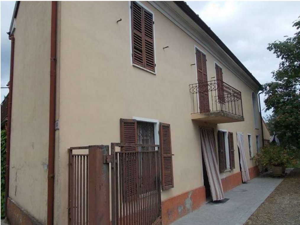
Foto 3 Prospetto sud/ovest fabbricato –ingresso pedonale/carraio
