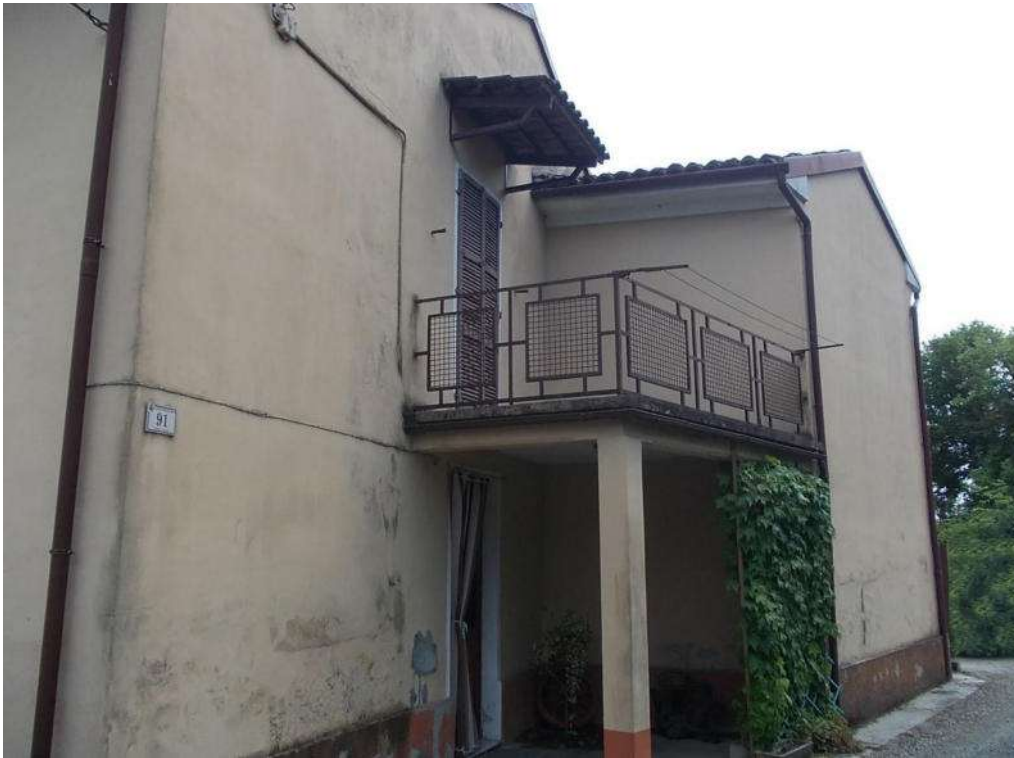
Foto 1 Prospetto ovest fabbricato da Strada Canale civ.91
