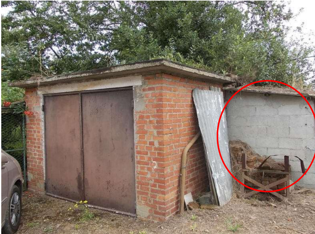
Foto 7 Prospetto nord box da cortile con fabbricato da regolarizzare
