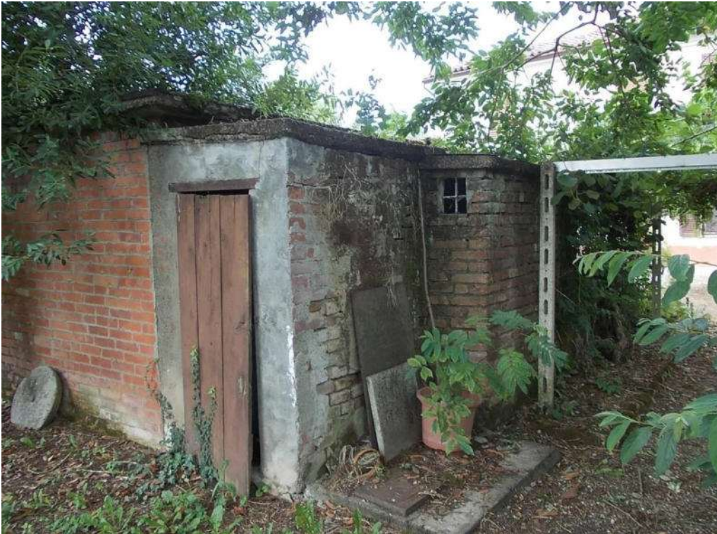
Foto 9 Prospetto sud/est box –locali sgombero
