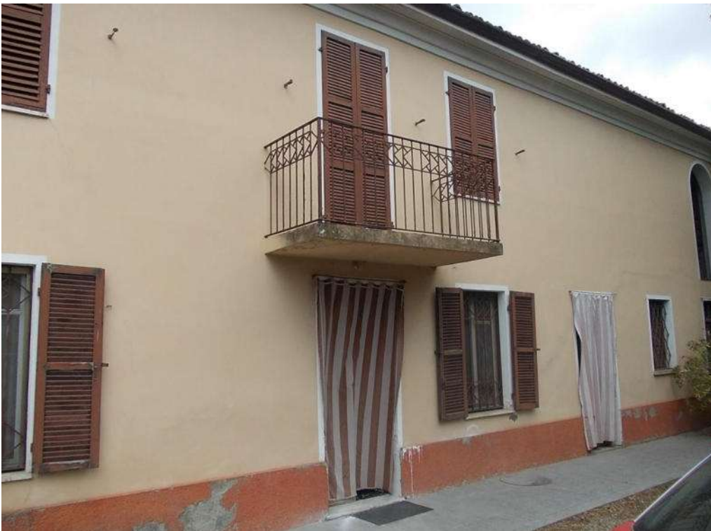
Foto 4 Prospetto sud fabbricato da cortile
