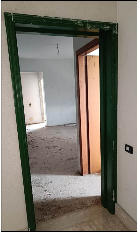
Ingresso dell'appartamento identificato al sub 27, oggetto di stima
