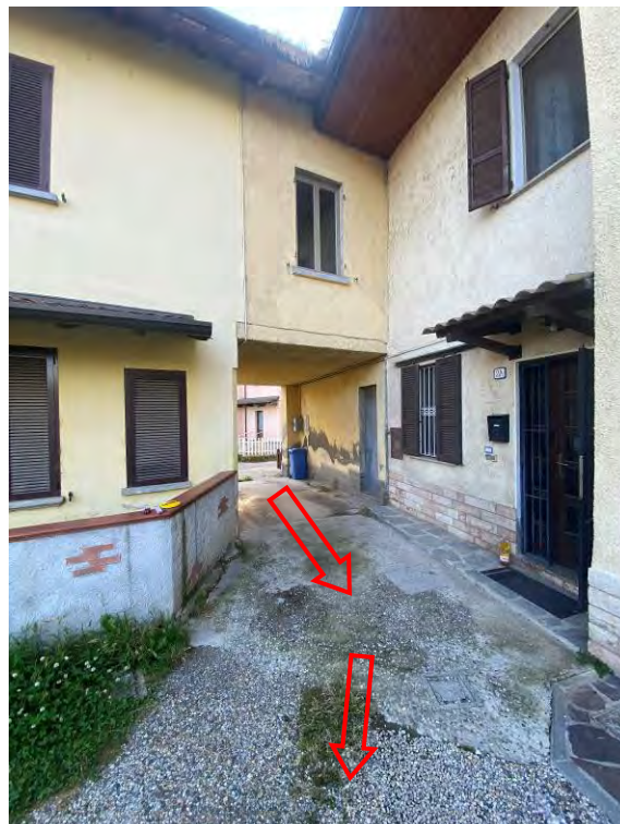
Immagine 06 – vista dalla corte comune (mappale 49 di N.C.T.) – prospetto Est
