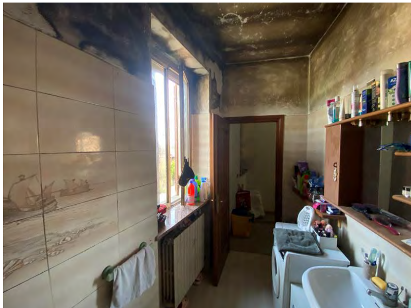
Immagine 26 – vista del bagno
