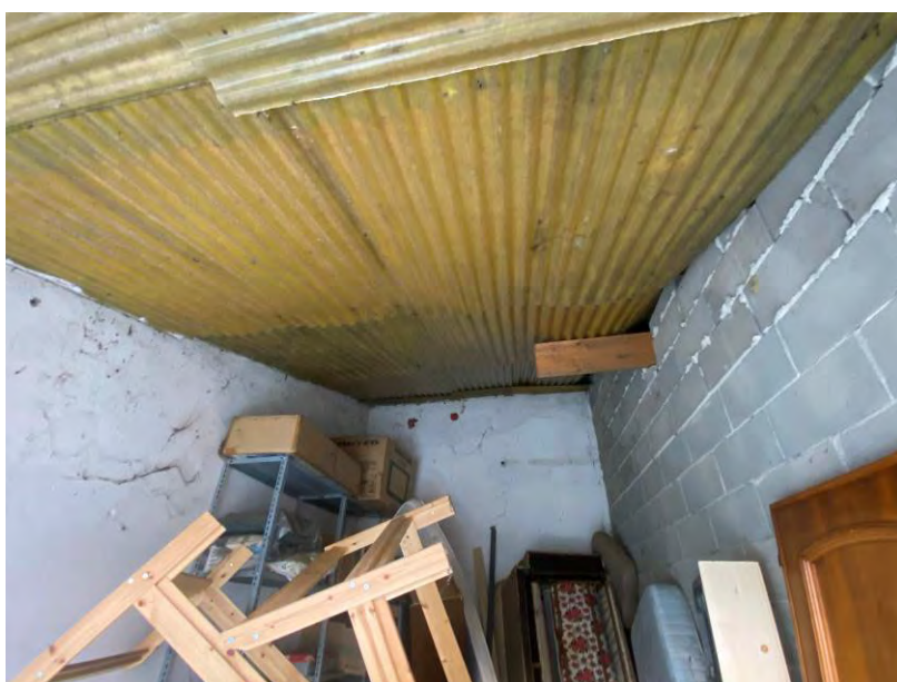
Immagine 12 – vista del box
