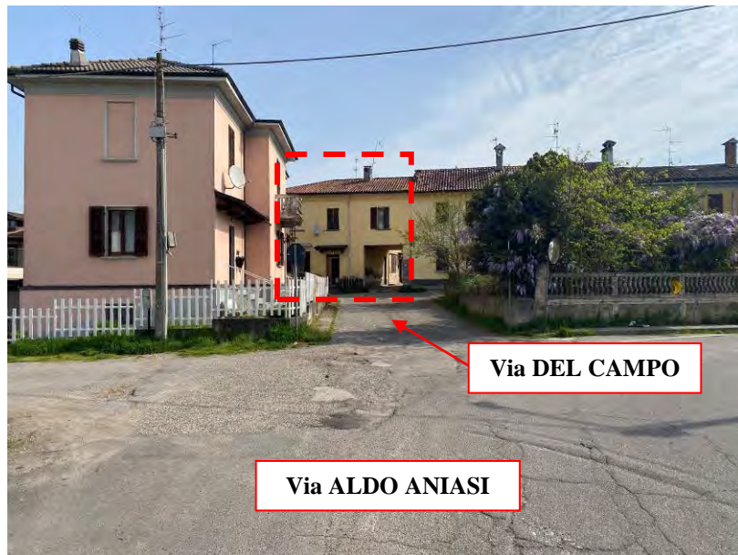
Immagine 01 – vista panoramica – posizione edificio principale (abitazione)
