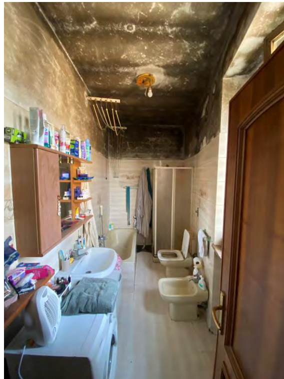
Immagine 25 – vista del bagno
