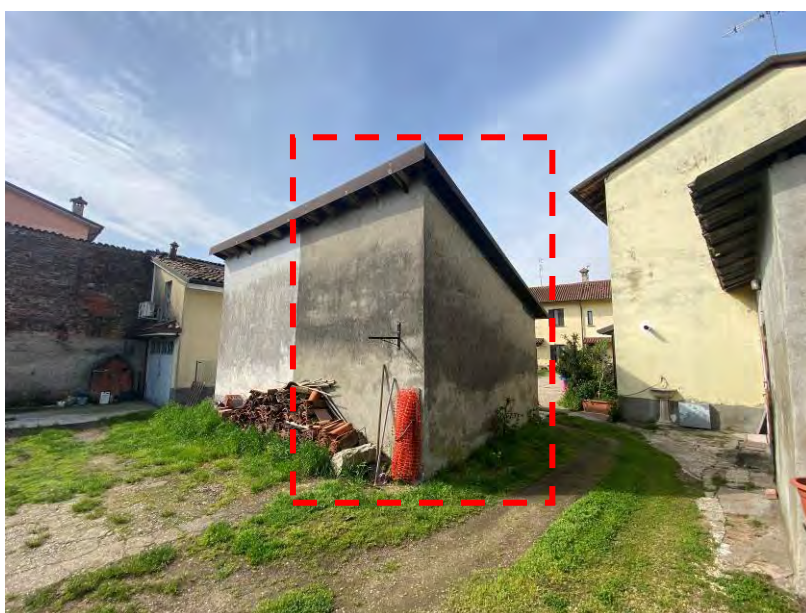
Immagine 10 – vista dalla corte (mappale 130 di N.C.T.) – prospetti Nord/Est
