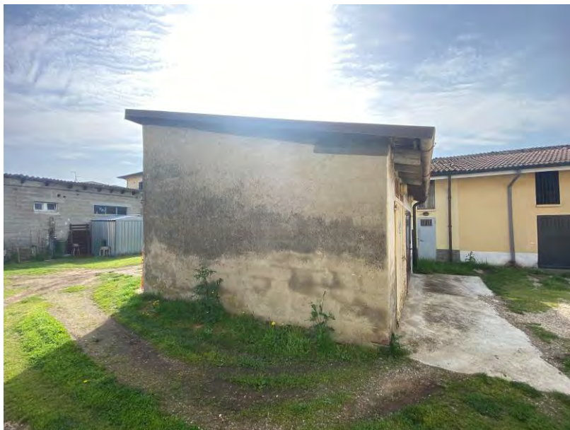
Immagine 09 – vista dalla corte (mappale 130 di N.C.T.) – prospetto Nord
