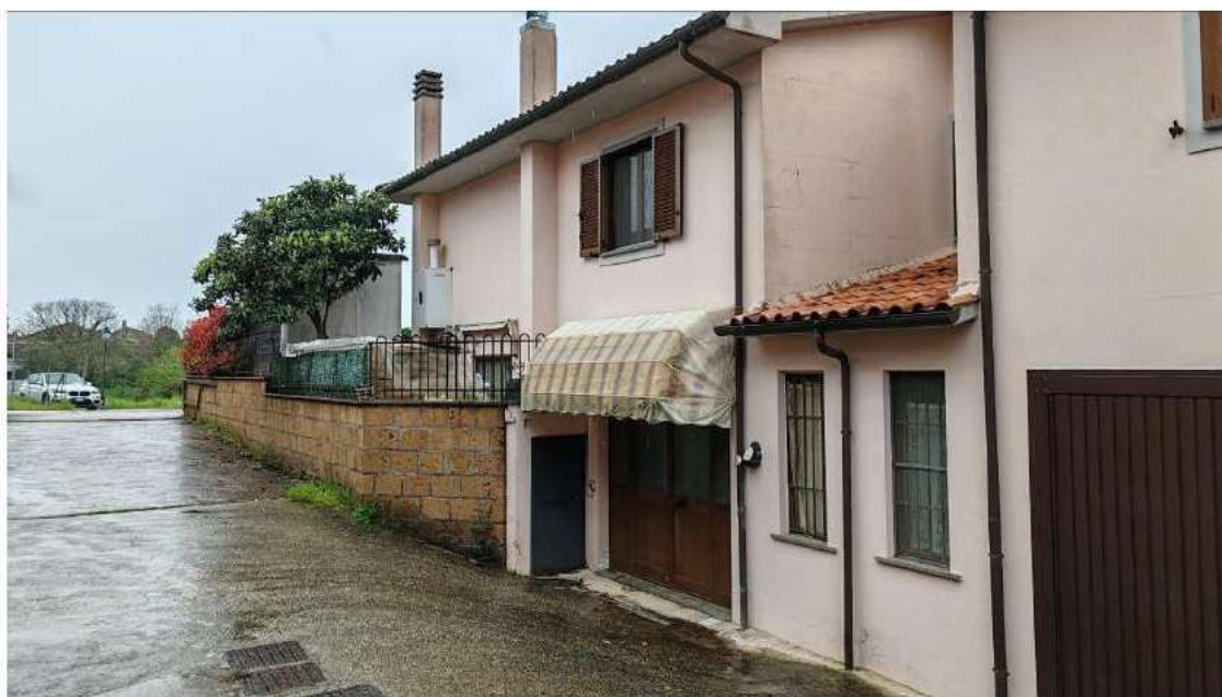
foto 5 - vista d'insieme dell'abitazione pignorata da sud-ovest.
