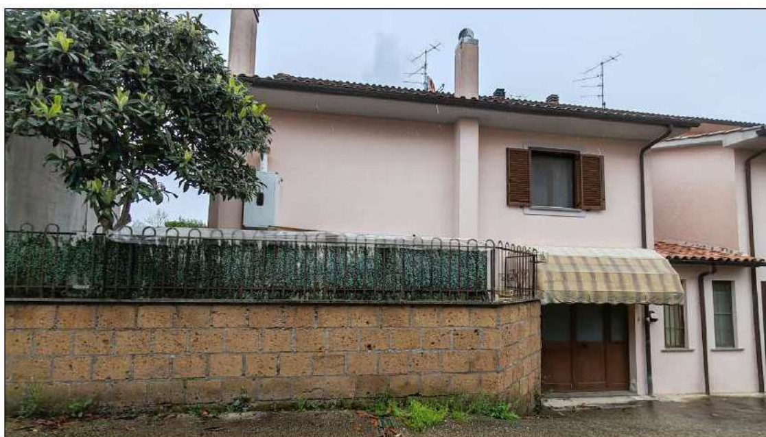
foto 4 - come sopra da ovest con l'accesso carrabile.
