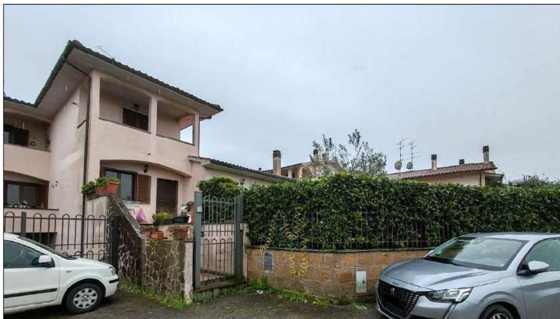
foto 1 - vista esterna da nord dell'abitazione pignorata con l'accesso pedonale.
