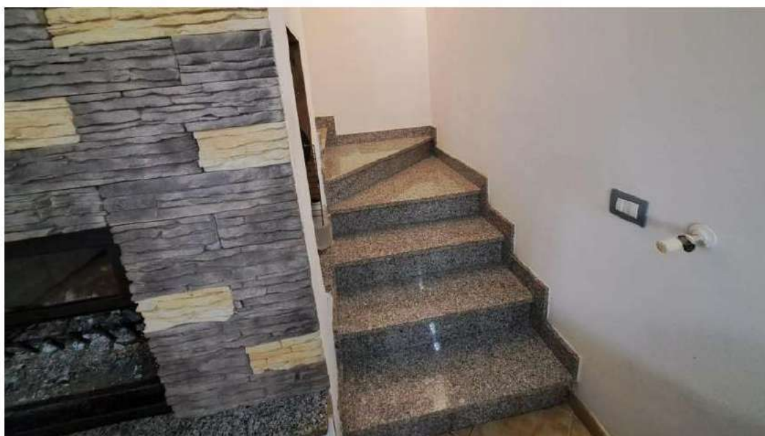
foto 12 - dettaglio scala che conduce al piano 1°.
