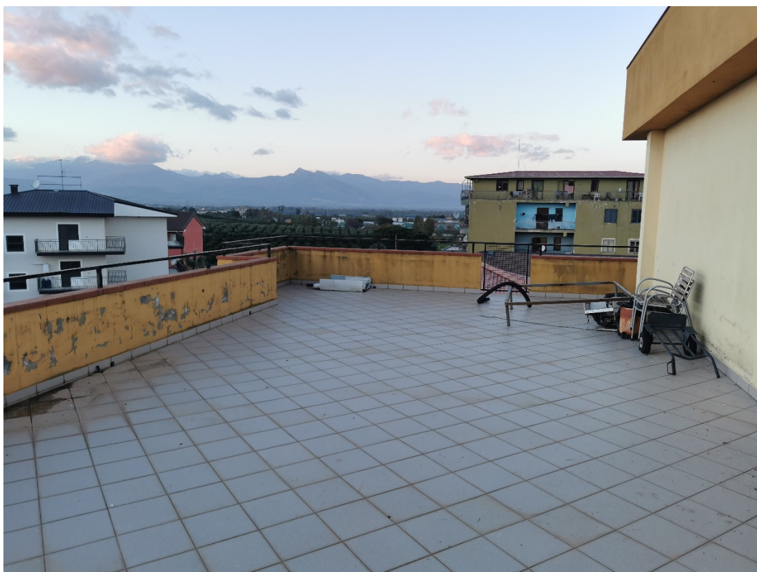
Foto 30: Appartamento in comune di Corigliano Rossano località Cantinella - Fg. 32 p.la 1594 sub 12 - terrazzo.
