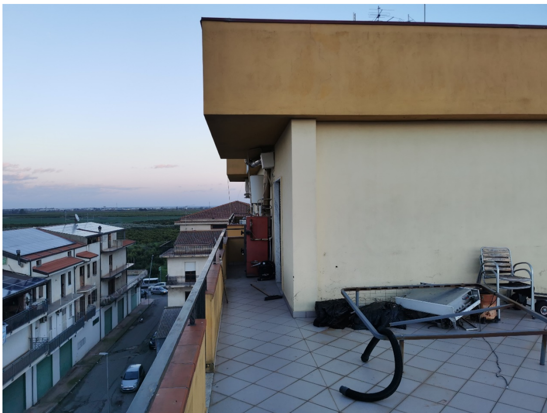
Foto 31: Appartamento in comune di Corigliano Rossano località Cantinella - Fg. 32 p.Ila 1594 sub 12 - terrazzo.
