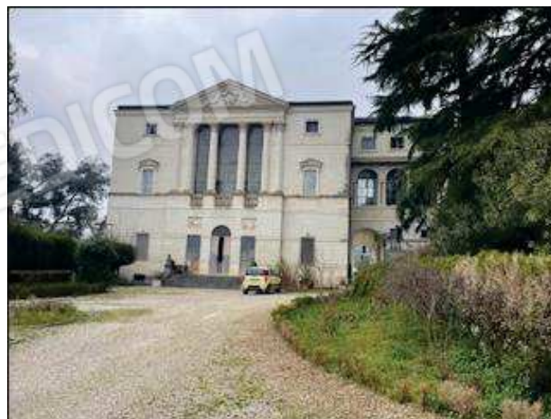
Corpo di fabbrica "E"
