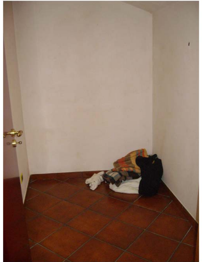
Foto n°18 -Piano sottotetto; locale ripostiglio;
