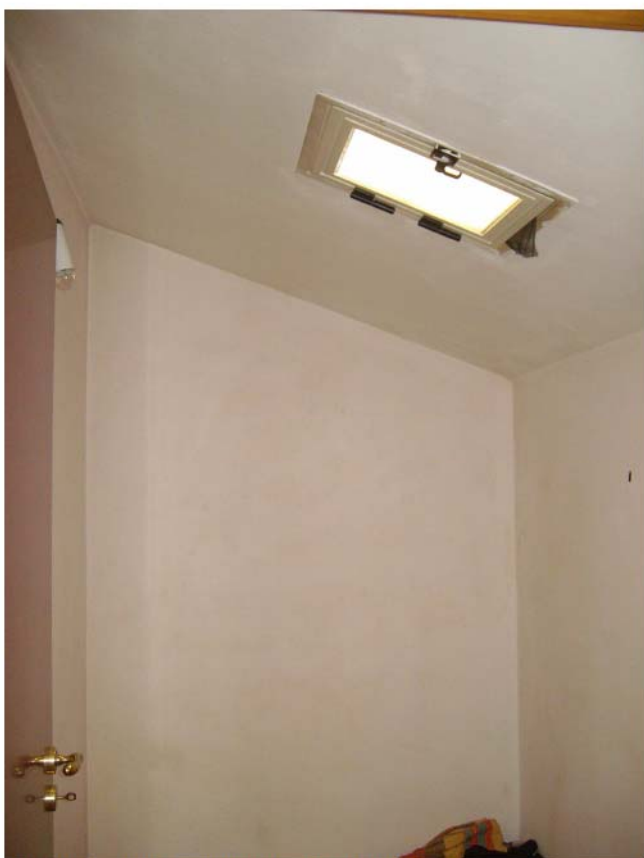
Foto n°19 - Piano sottotetto; locale ripostiglio;
