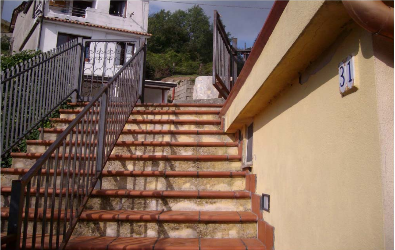
Foto n°3 - Scala esterna di accesso all'Immobile; altra Vista;
