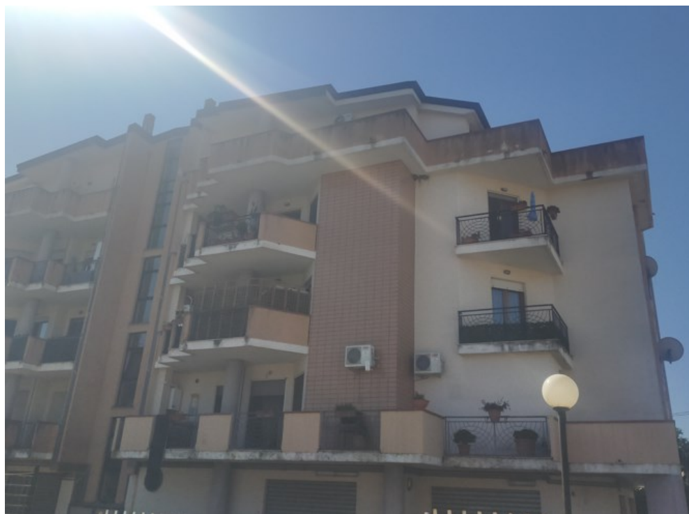
Figura N° 7 - FOTO EDIFICIO COMUNE DI MONTALTO UFFUGO - FOGLIO 61 - PART. 672
