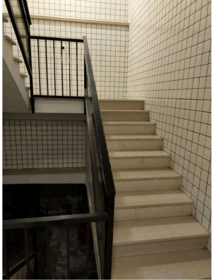
Vista del vano scala condominiale
