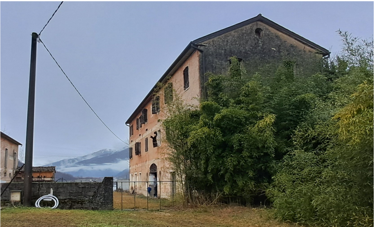
Vista del cancello esistente sul lato est del mapp. 719
