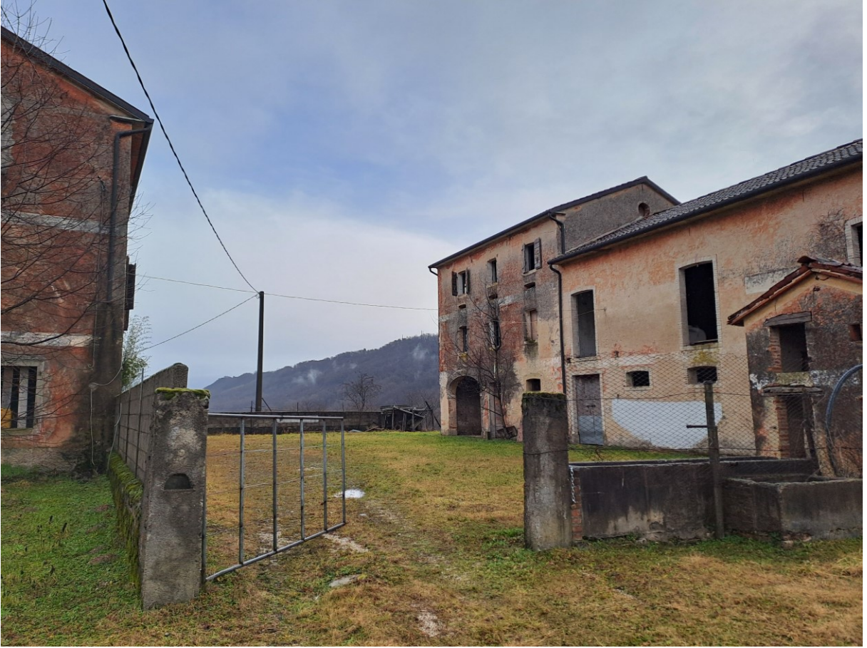
Vista del cancello esistente sul lato ovest del mapp. 719
