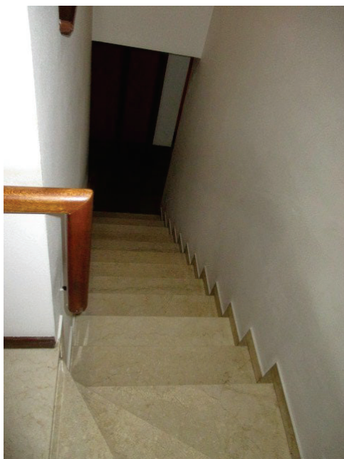
Scala di servizio
