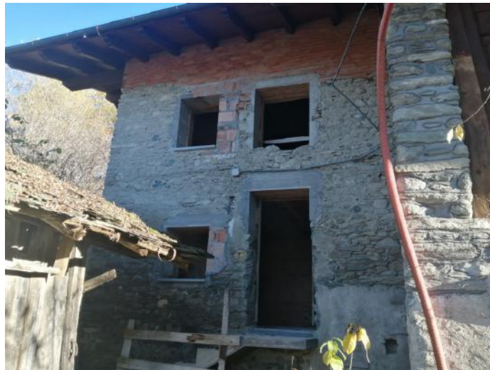
Esterno (lato nord)
