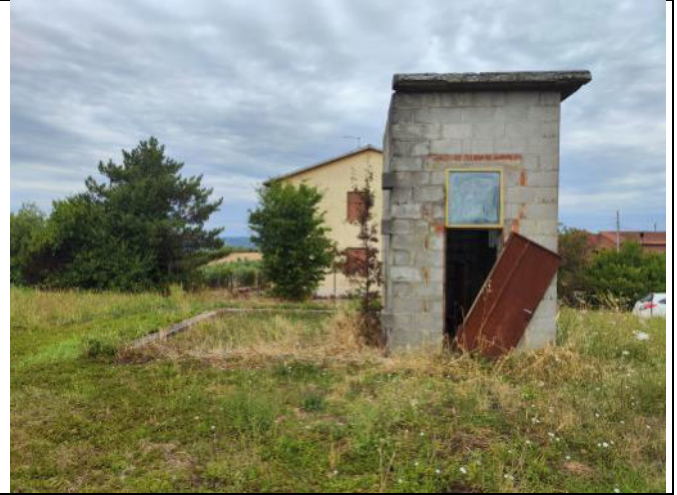
Volume per autoclave con deposito interrato dell'acqua
