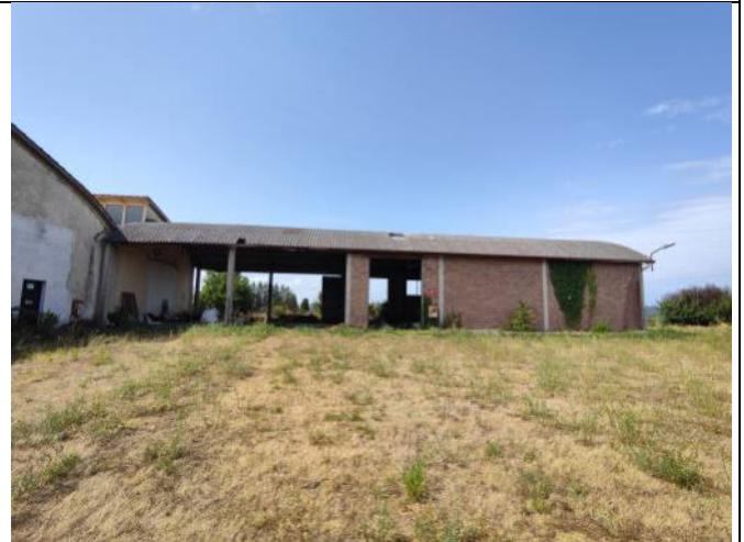
Magazzino esterno ( Parte sub. 12 e parte sub. 10
