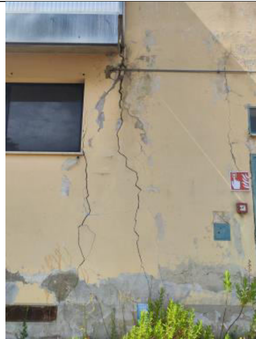
Problemi di stabilità cabina elettrica
