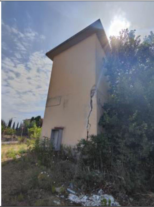
Evidente Crepa su spigolo retrostante della cabina elettrica
