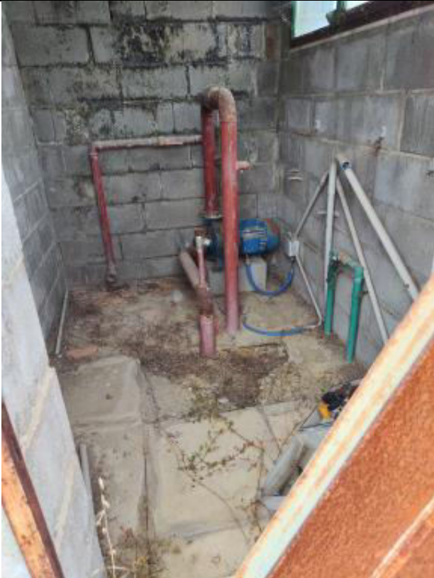
Autoclave dismessa a servizio dell'impianto antincendio collegato con cisterna interrata
