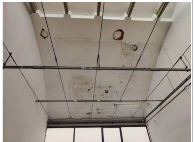
COPERTURA LAVORAZIONE CON BURATTI 1
