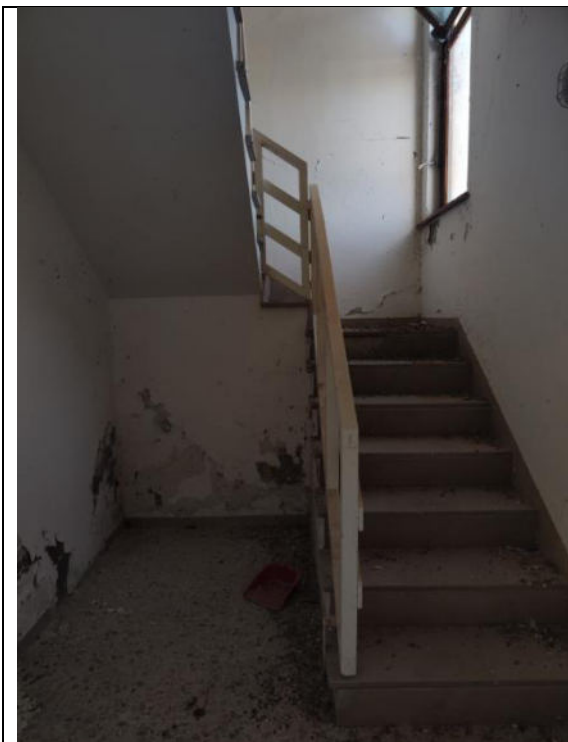
SCALA DI SALITA ALL'ABITAZIONE AL PIANO PRIMO
