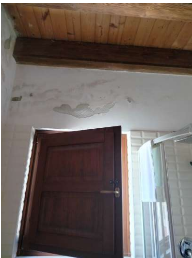
Parete Bagno al piano primo
