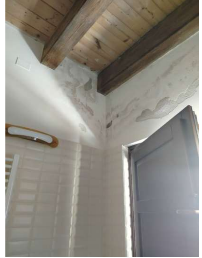
Parete Bagno al piano primo
