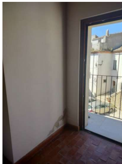
Parete al Piano Secondo
