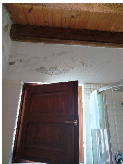
Parete Bagno al piano primo
