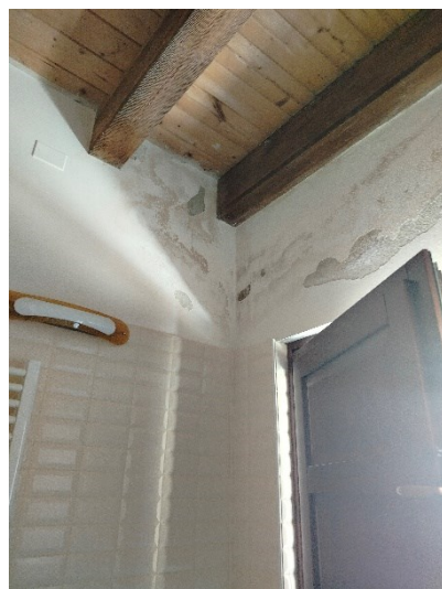
Parete Bagno al piano primo
