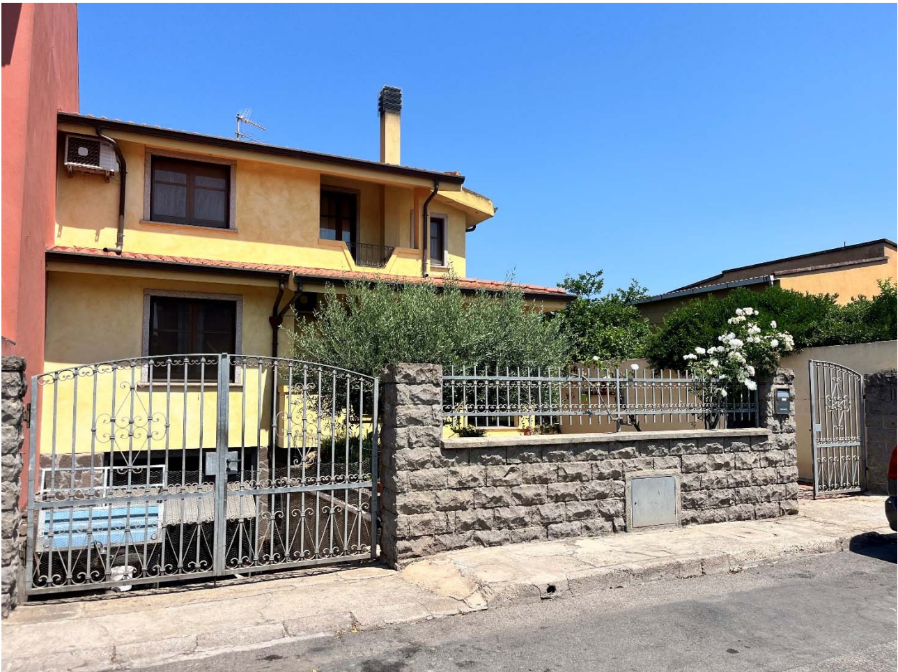
Prospetto principale sulla via Terranova
