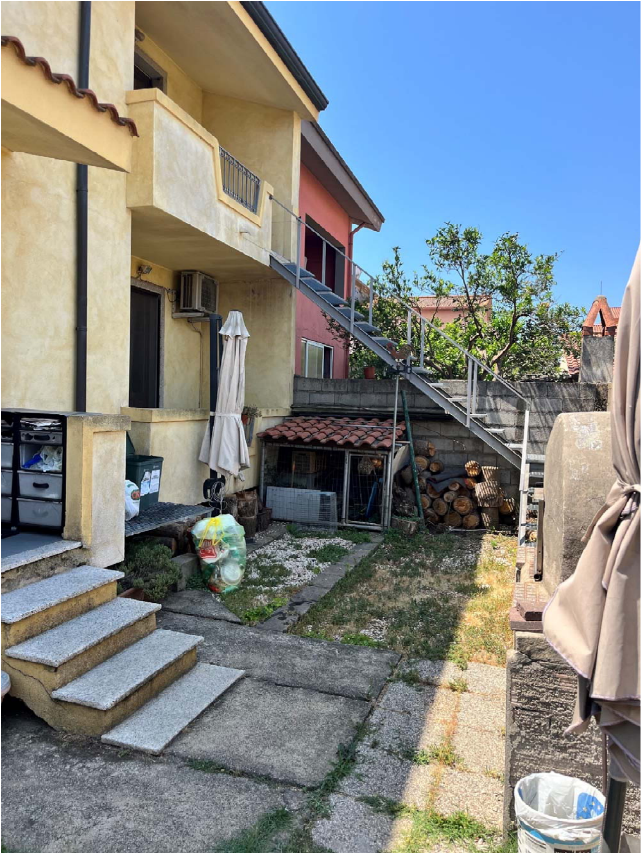
Prospetto posteriore ovest
