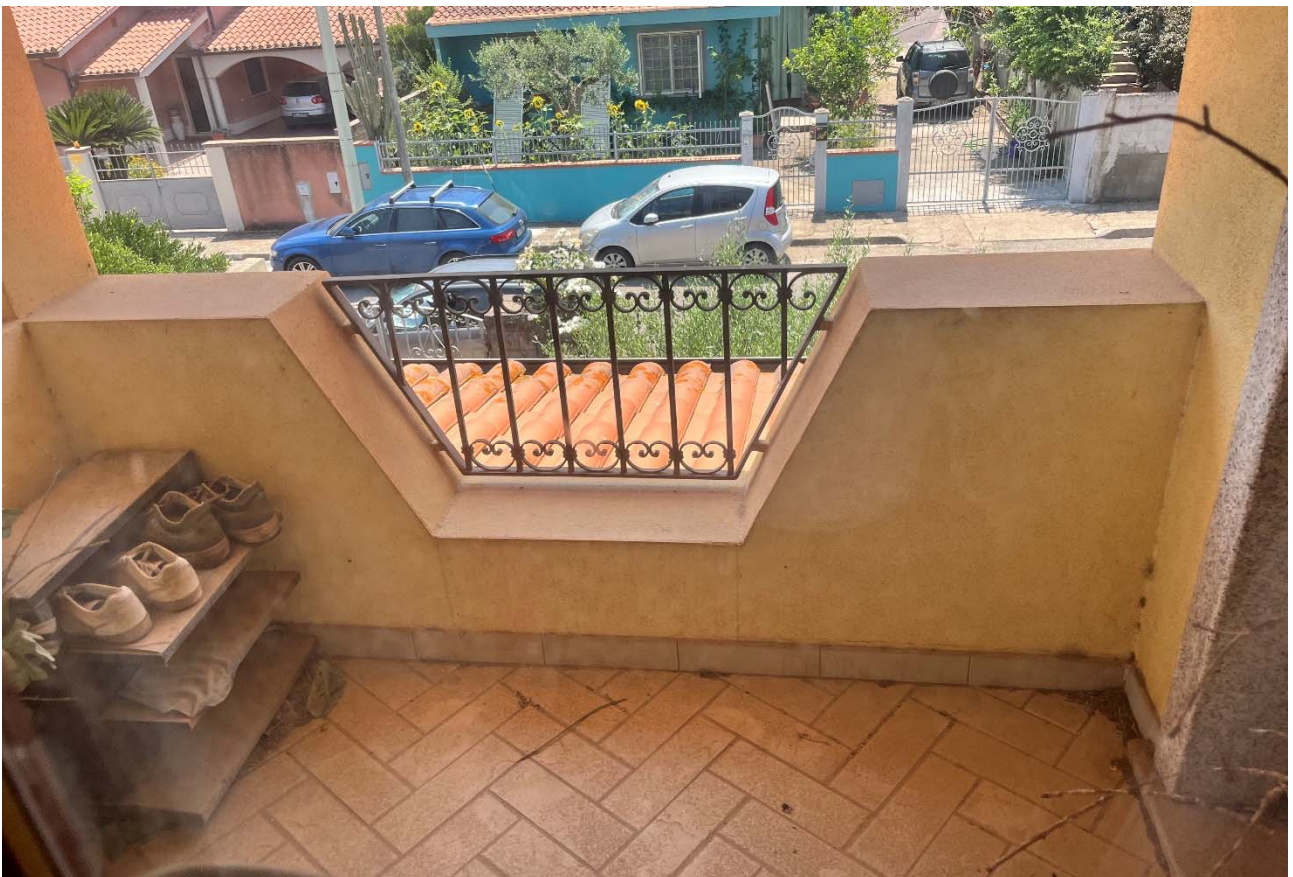
Veranda piano primo
