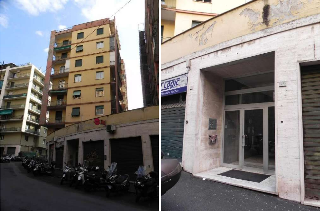
Foto 9 e 10 – Viste del condominio di Via Manunzio 17 e del portone di ingresso
