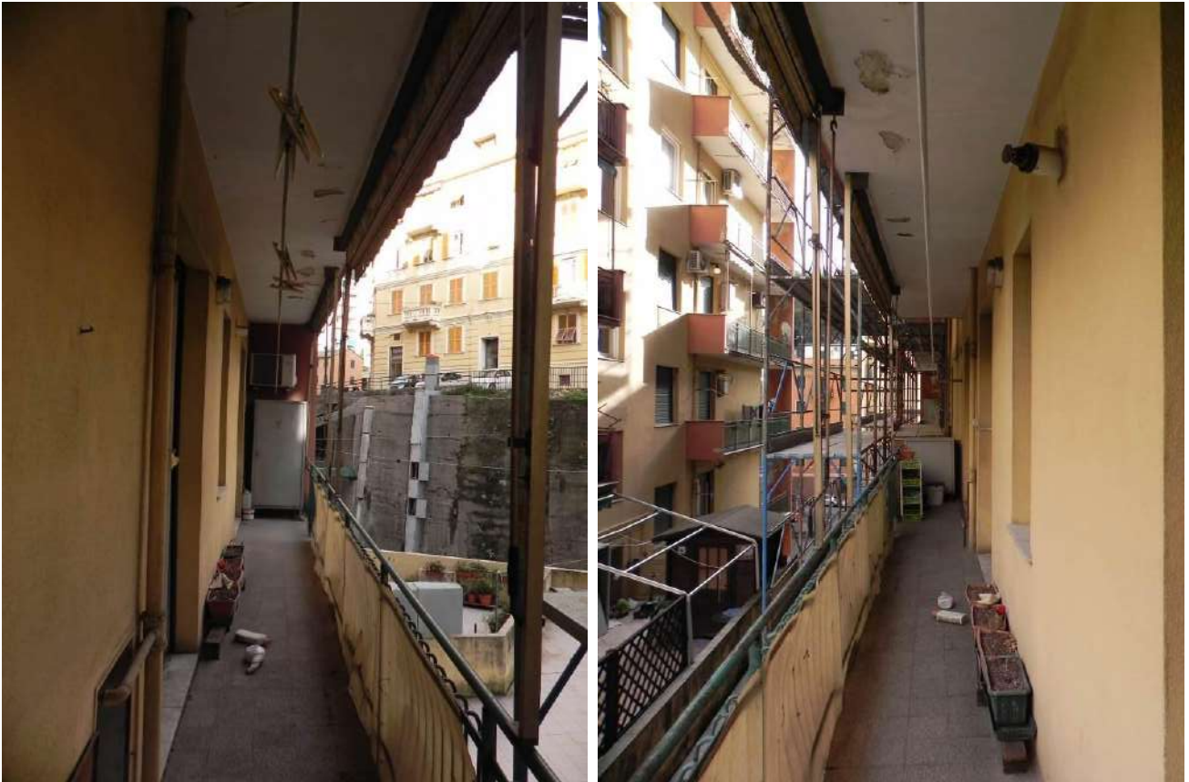
Foto 21 e 22 – Viste della balconata sul distacco
