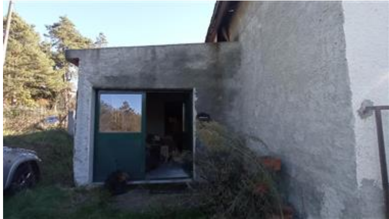
Locale deposito sul fronte nord
