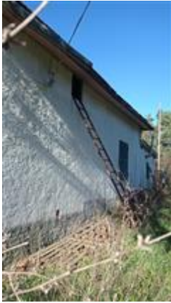
Fronte est con accesso al sottotetto
