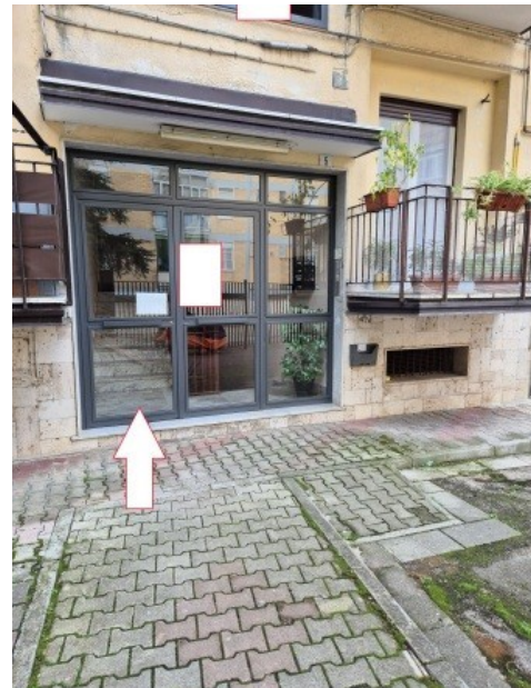
Figura 7 accesso alla scala C della palazzina n.6 in via Tevere n.5 - Caserta
