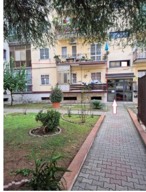
Figura 4 accesso alla scala C della palazzina n.6 da via Tevere in Caserta e facciata della scala C
