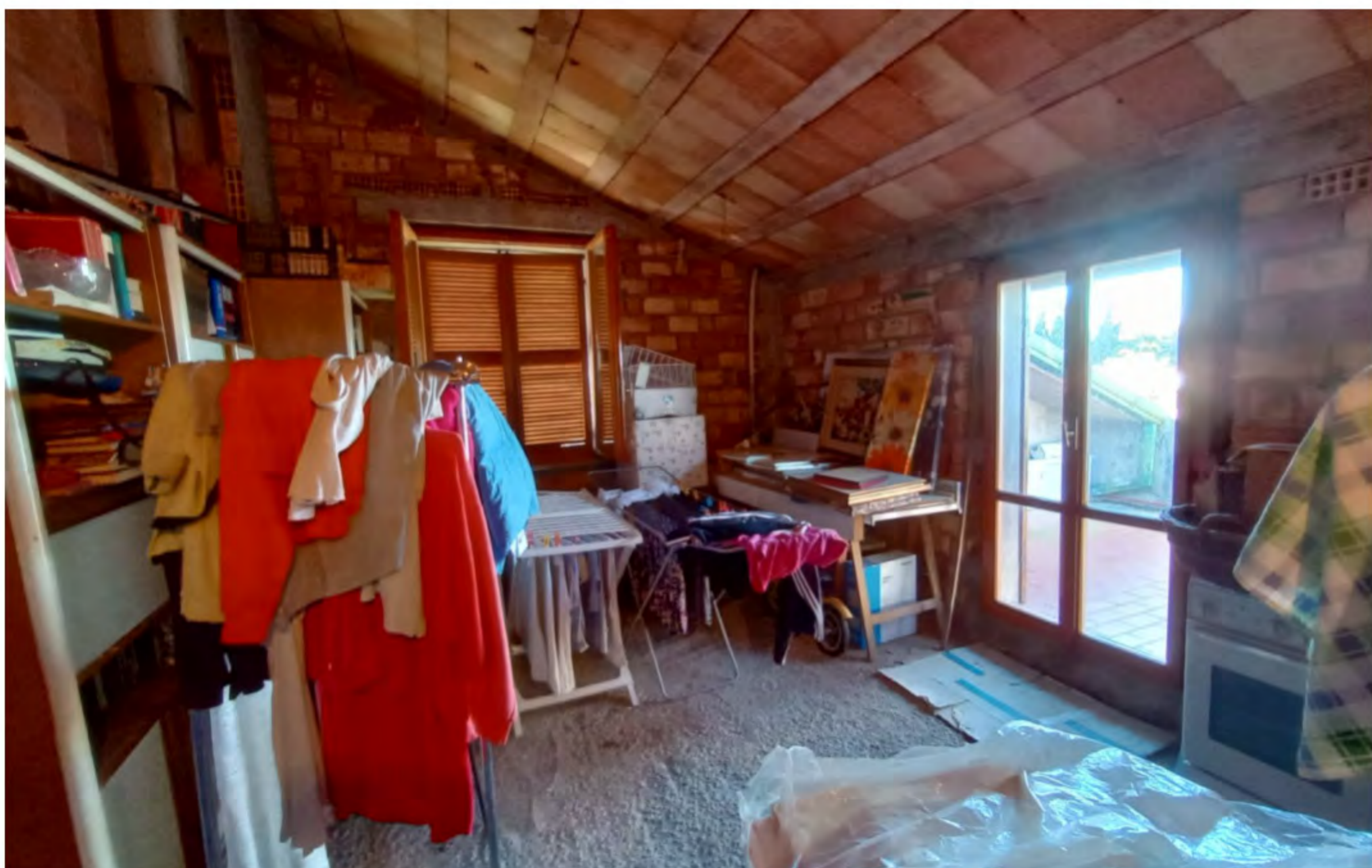
Piano Primo - Vano soffitta
