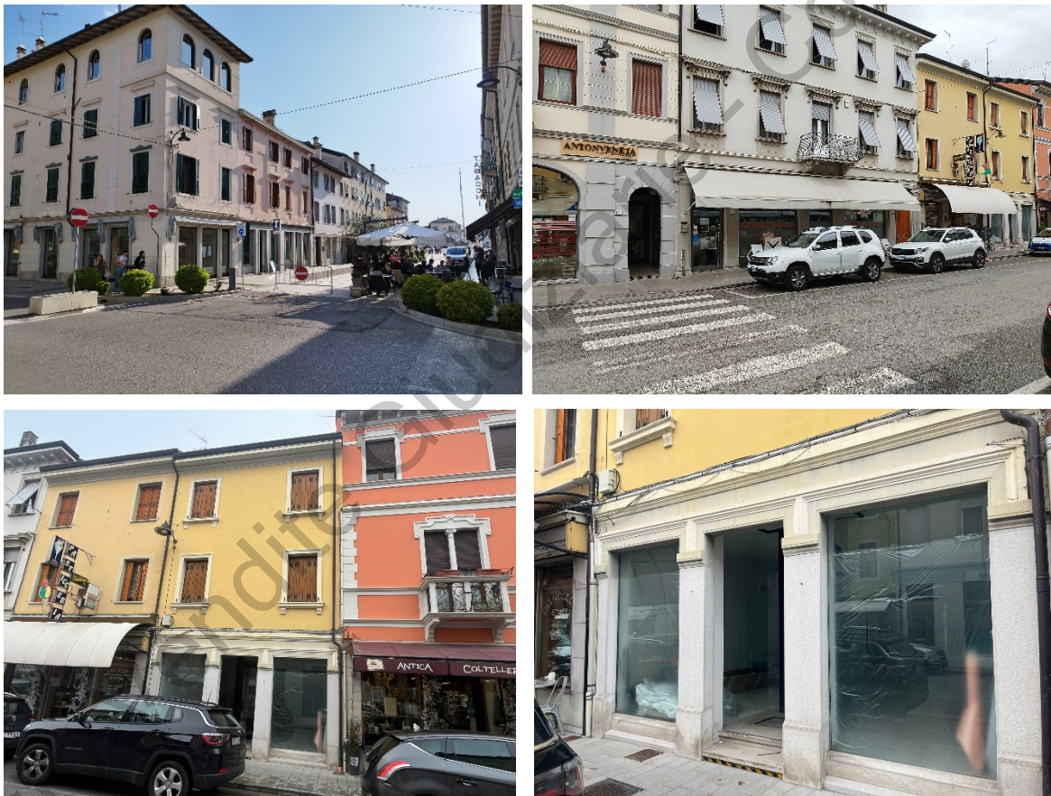
Vista di Borgo Aquileia e del prospetto principale
