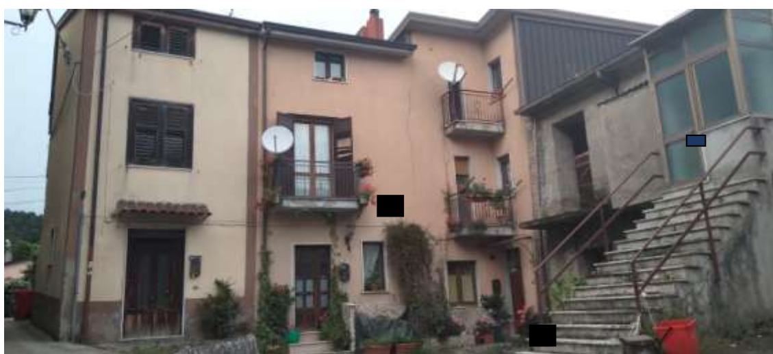
Foto n. 3 Vista dallo slargo comunale
