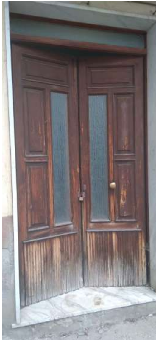
Foto n. 5 Particolare porta di ingresso
