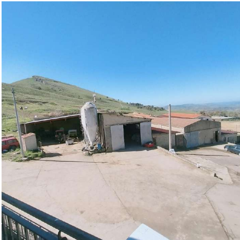
FOTO N.5: EDIFICIO 3 VISTA DALL'ALTO (MAGAZZINI E DEPOSITO)
