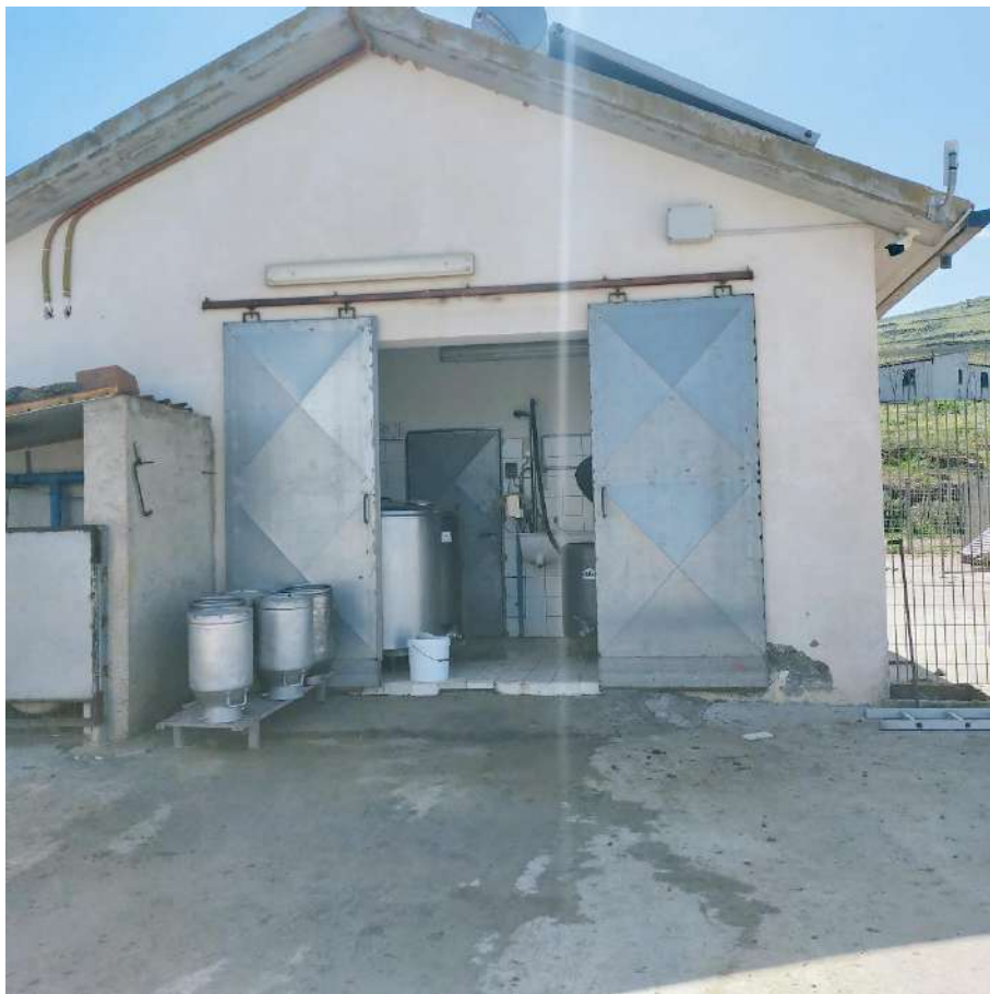
FOTO N.25: EDIFICIO 11 VISTA FRONTALE (SALA MUNGITURA)
