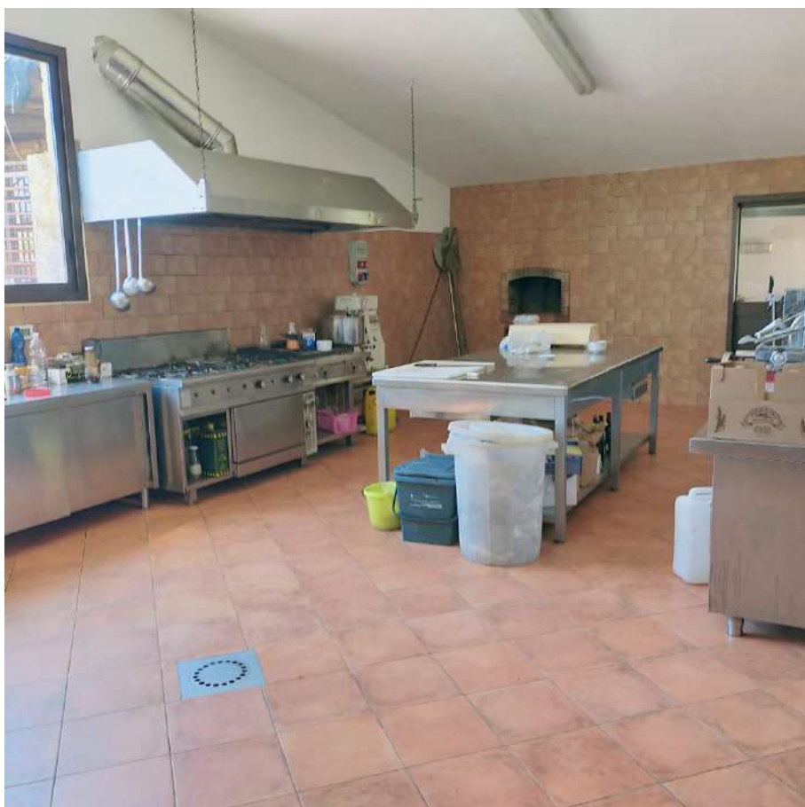
FOTO N.13: EDIFICIO 6 CUCINA (EDIFICIO RISTORAZIONE)
