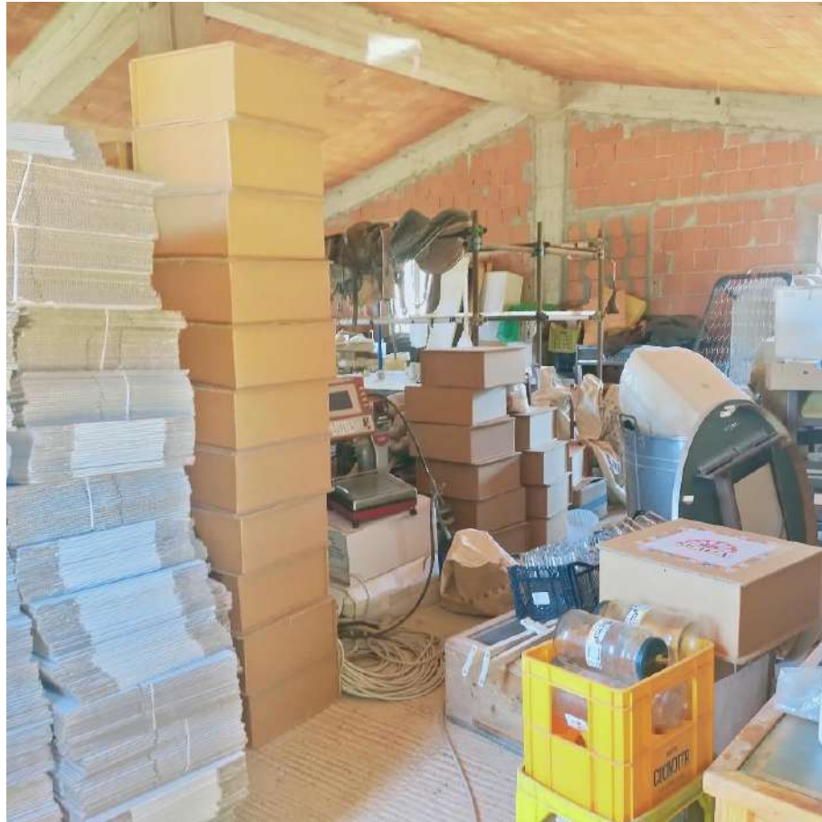
FOTO N.8: EDIFICIO 4 PIANO PRIMO (ABITAZIONE SUB.2)
