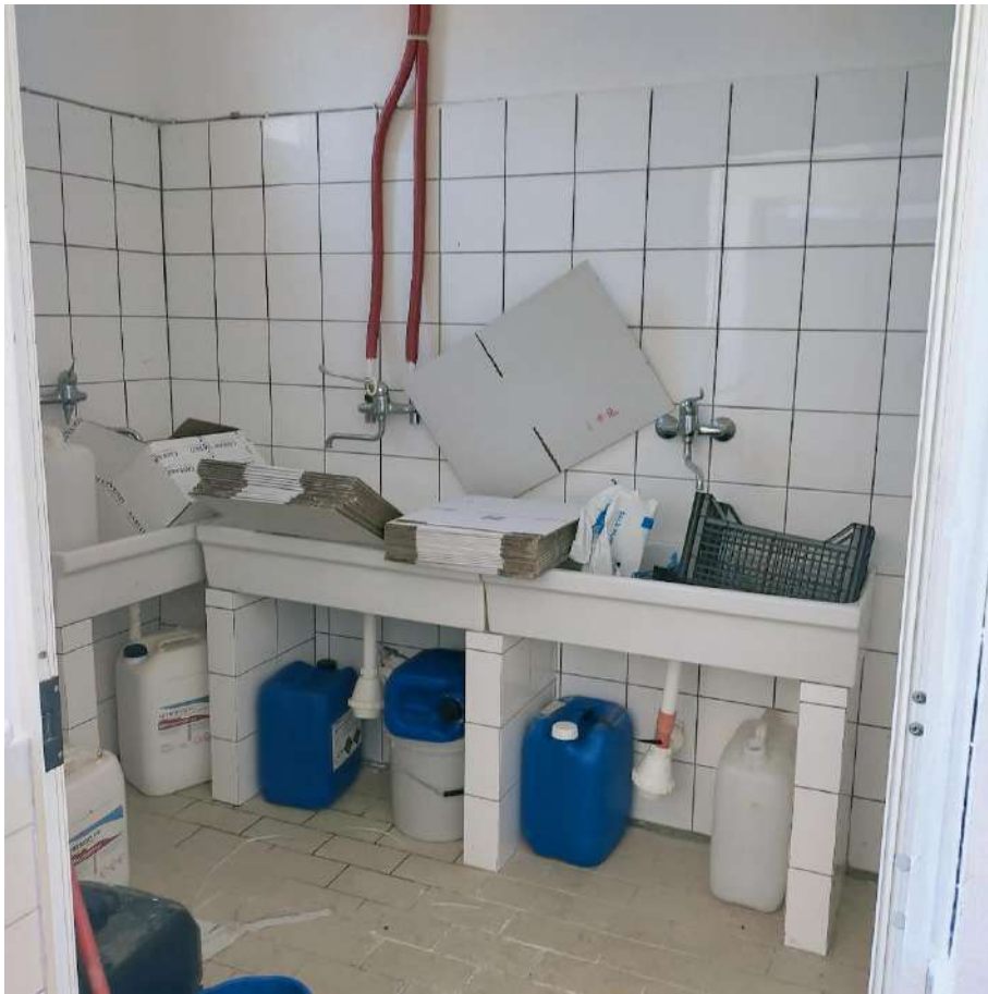
FOTO N.23: EDIFICIO 10 INTERNO (CASEIFICIO)
