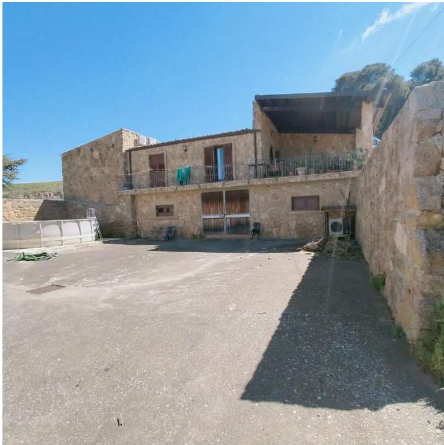
FOTO N.17: EDIFICIO 7 PROSPETTO LATERALE VISTA DALLA CORTE INTERNA (ABITAZIONE SUB.2)
