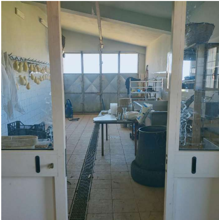
FOTO N.14: EDIFICIO 6 PREPARAZIONE FORMAGGI (SALA RISTORAZIONE)
