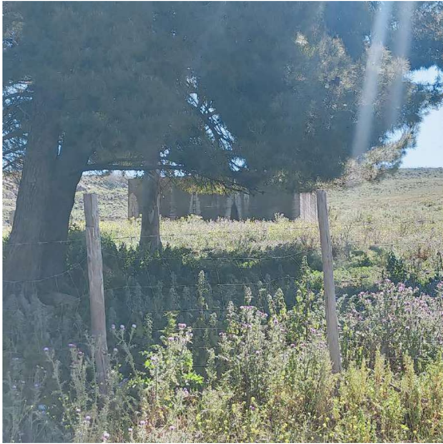
FOTO N.19: EDIFICIO 8 VISTA FRONTALE (VASCA ACQUA)
