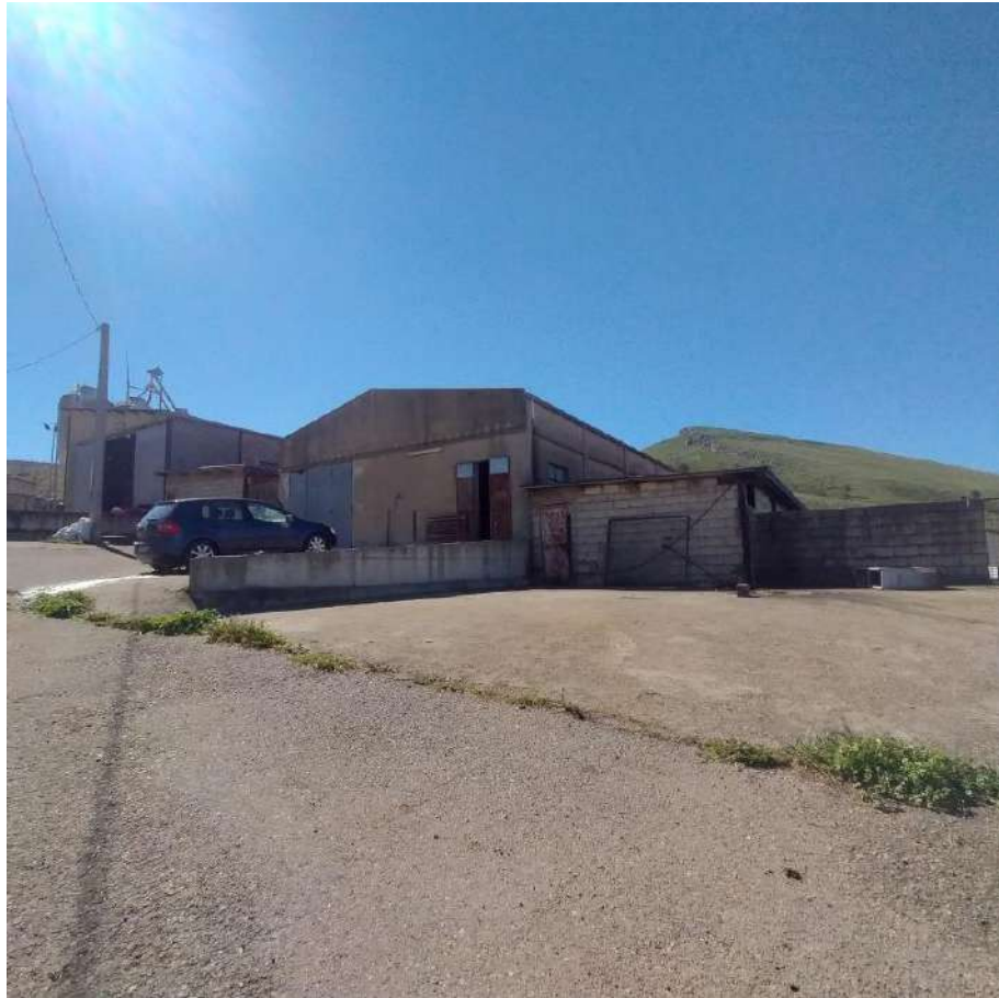
FOTO N.4: EDIFICIO 3 VISTA FRONTALE (MAGAZZINI E DEPOSITO)
