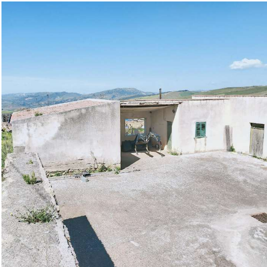
FOTO N.16: EDIFICIO 7 PROSPETTO LATERALE (MAGAZZINI SUB 1)
