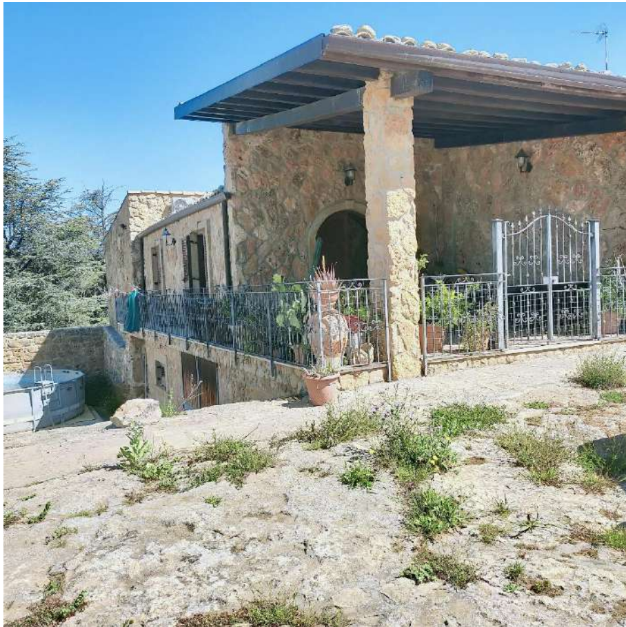
FOTO N.15: EDIFICIO 7 PROSPETTO LATERALE (ABITAZIONE)
