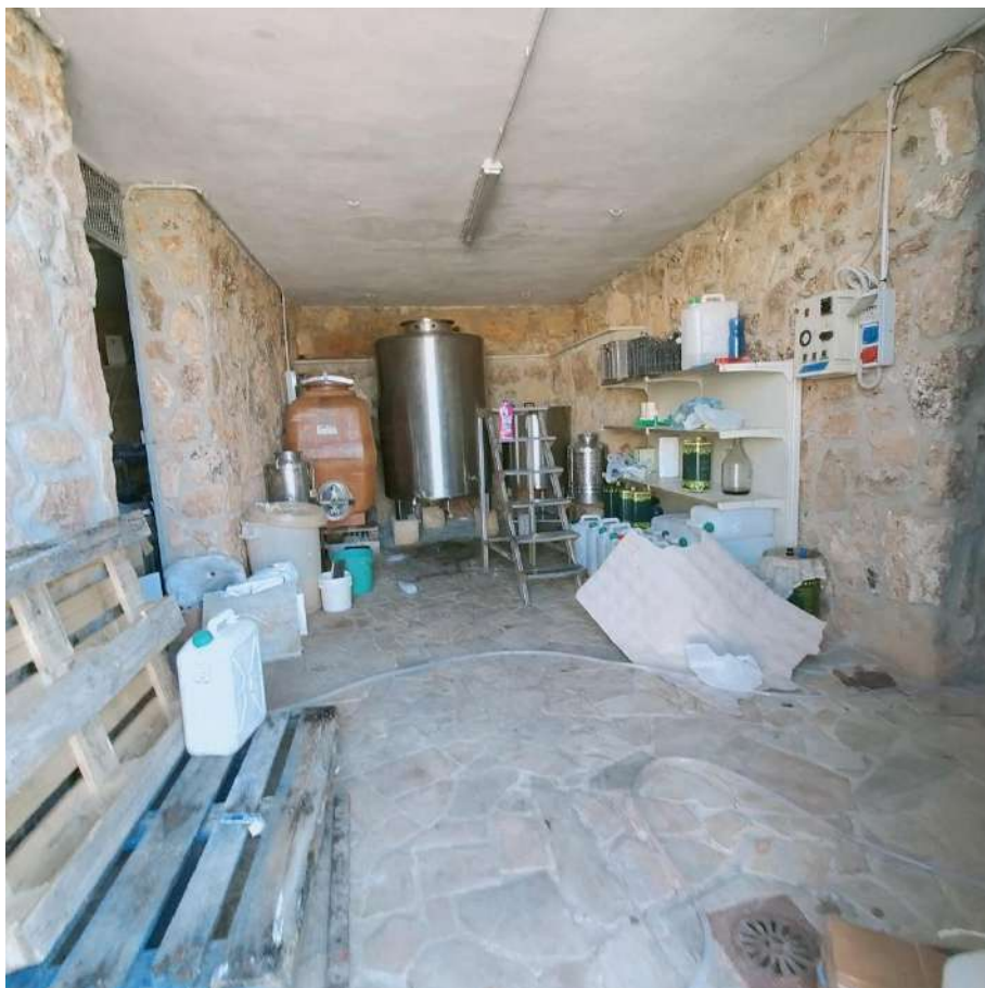
FOTO N.18: EDIFICIO 7 VANO PIANO TERRA (ABITAZIONE SUB.2)
