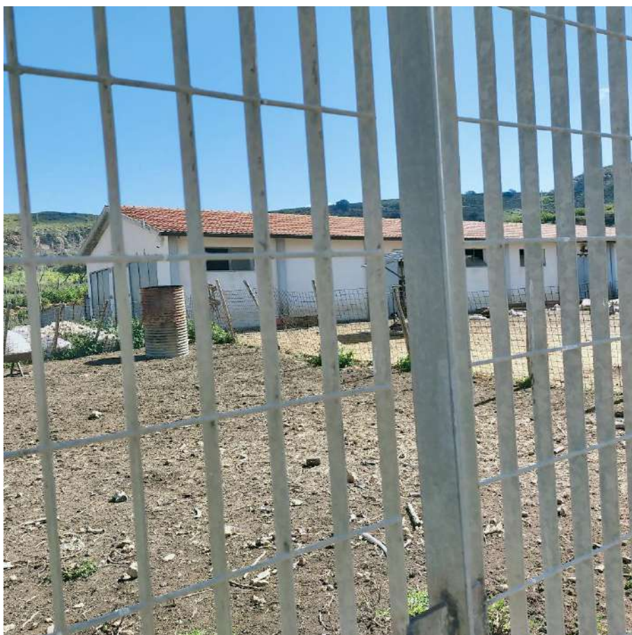
FOTO N.26: EDIFICIO 12 VISTA LATERALE (STALLONE)
