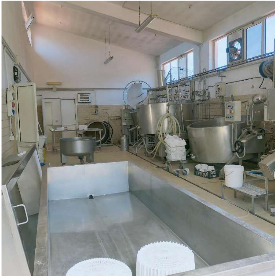
FOTO N.21: EDIFICIO 10 INTERNO (CASEIFICIO)
