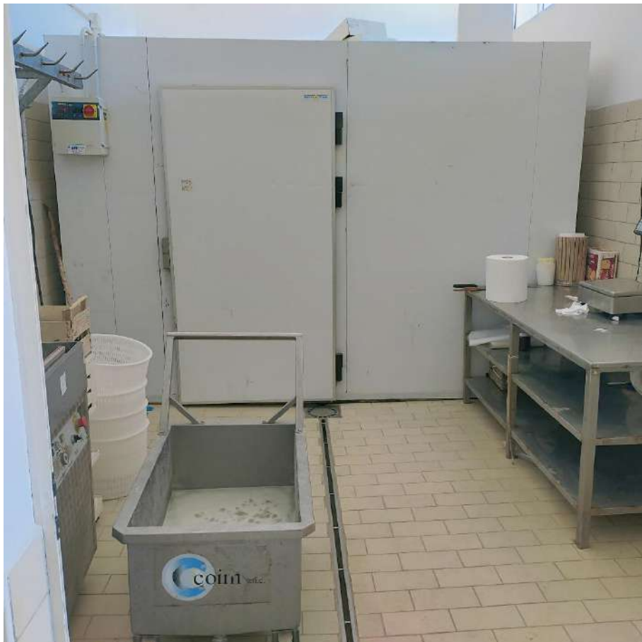
FOTO N.22: EDIFICIO 10 INTERNO (CASEIFICIO)
