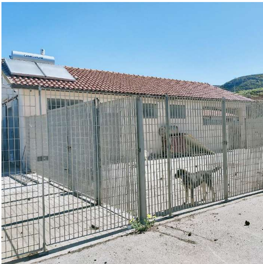
FOTO N.24: EDIFICIO 11 VISTA LATERALE (SALA MUNGITURA)
