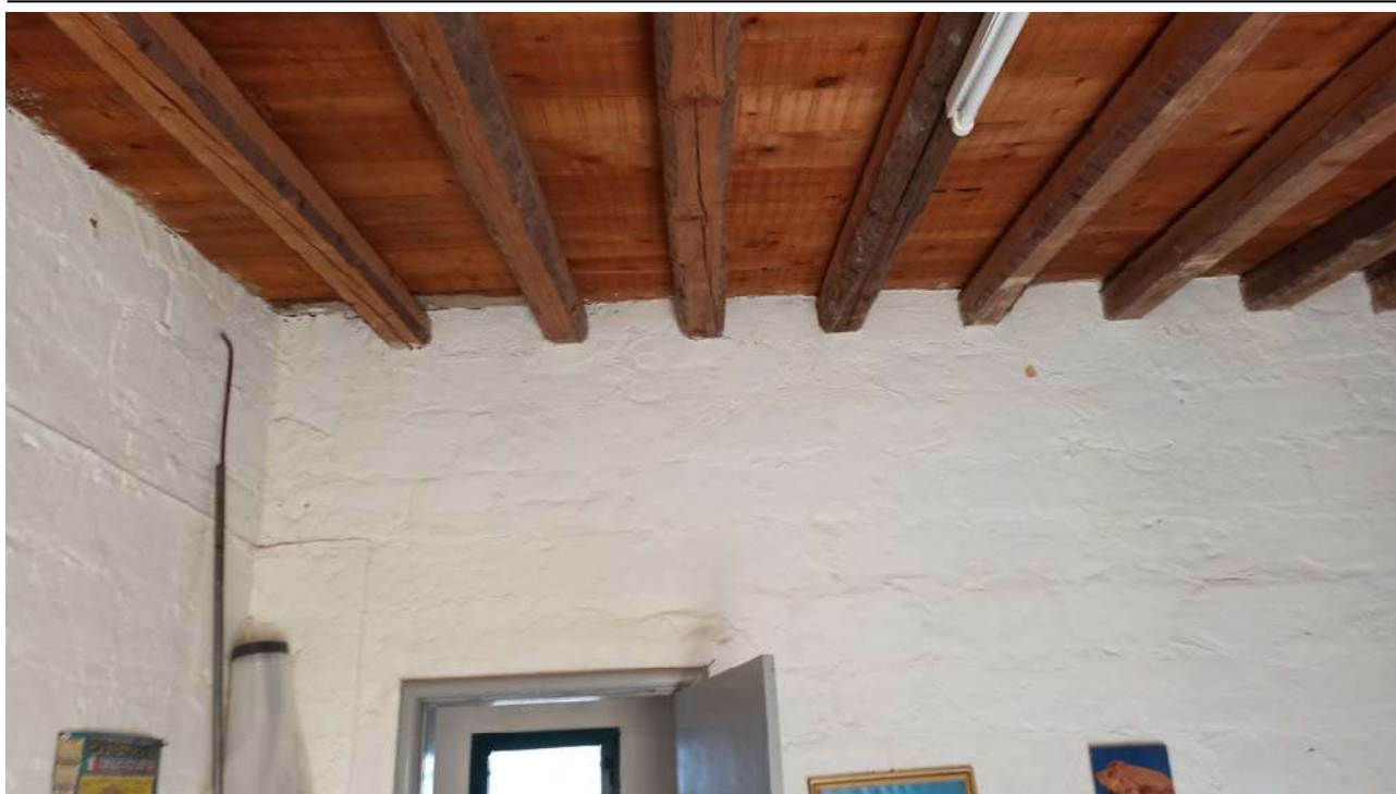
Cespite n° 2 – fabbricato
