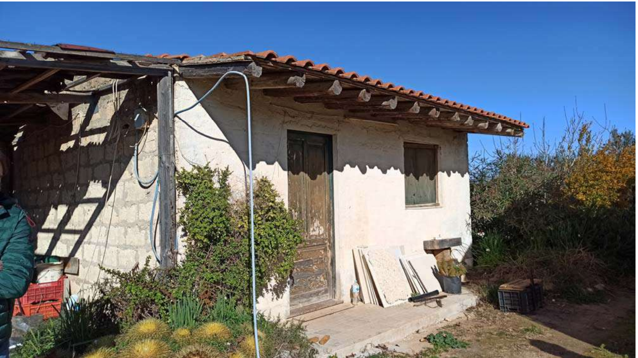
Cespite n° 2 – fabbricato
