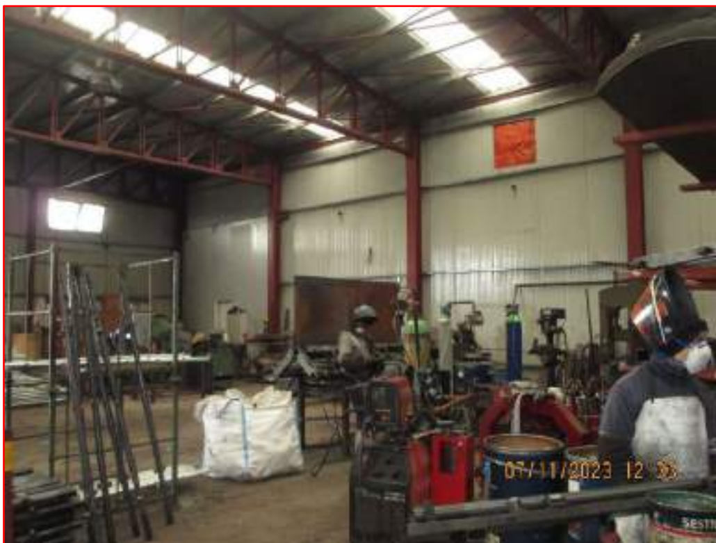
Opificio, Interno - particolare della copertura in capriate di acciaio a doppia falda intervallato da lastre di plexiglass per illuminazione.
