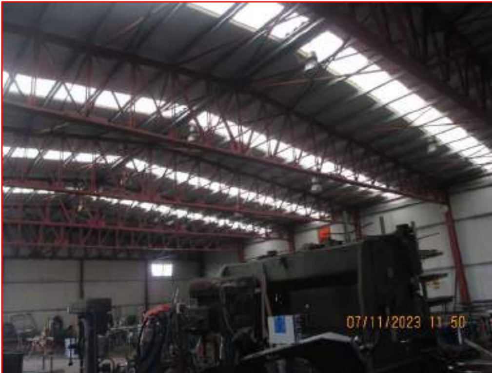
Opificio, Interno - particolare della copertura in capriate di acciaio a doppia falda intervallato da lastre di plexiglass per illuminazione.
