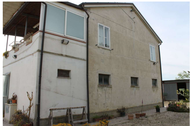
LATO EST FABBRICATO
