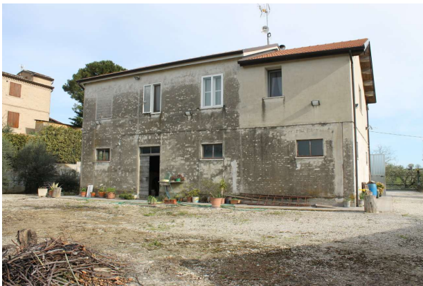
LATO NORD FABBRICATO
