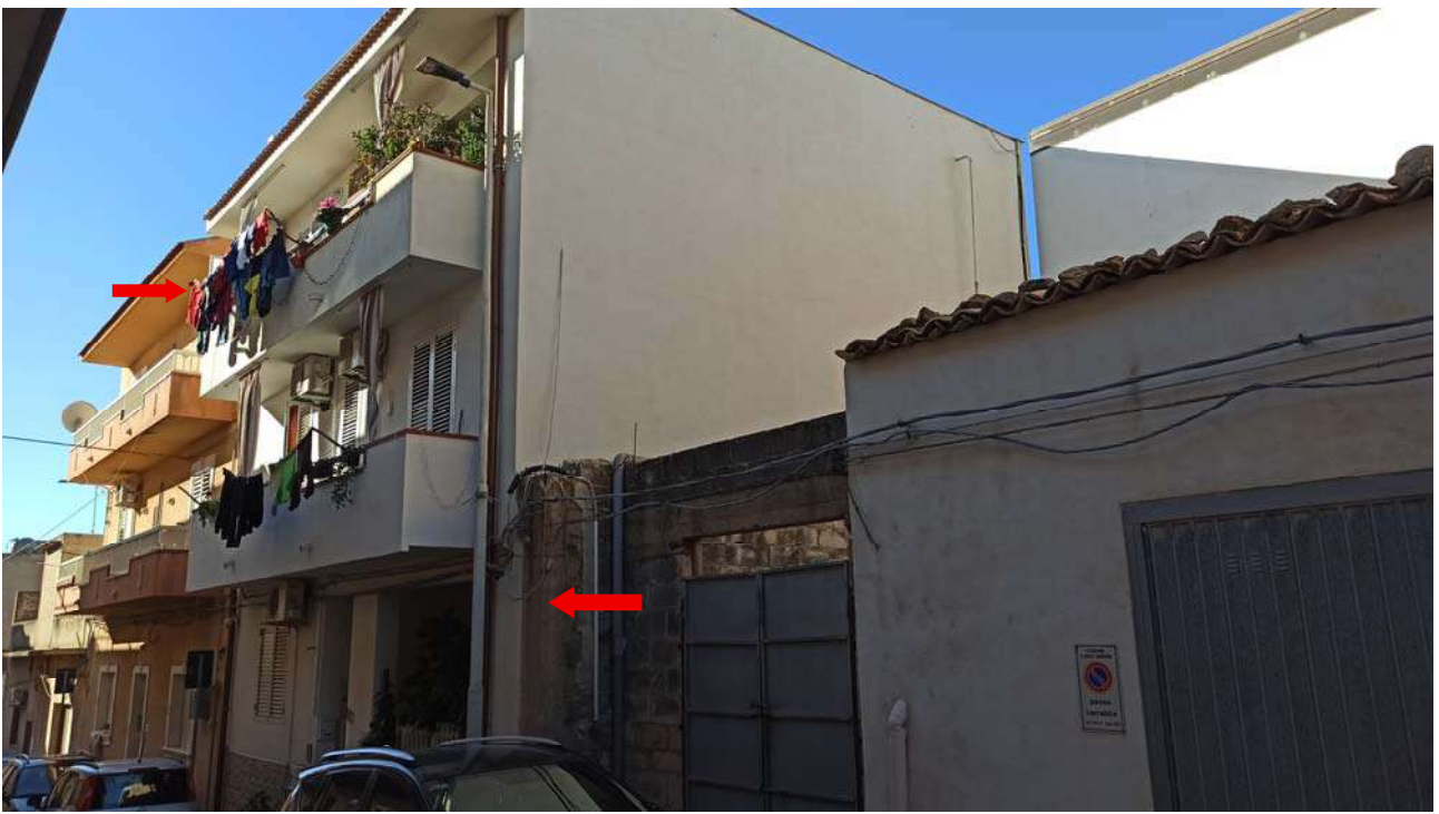
Cespite n° 1 - Prospetto immobile
