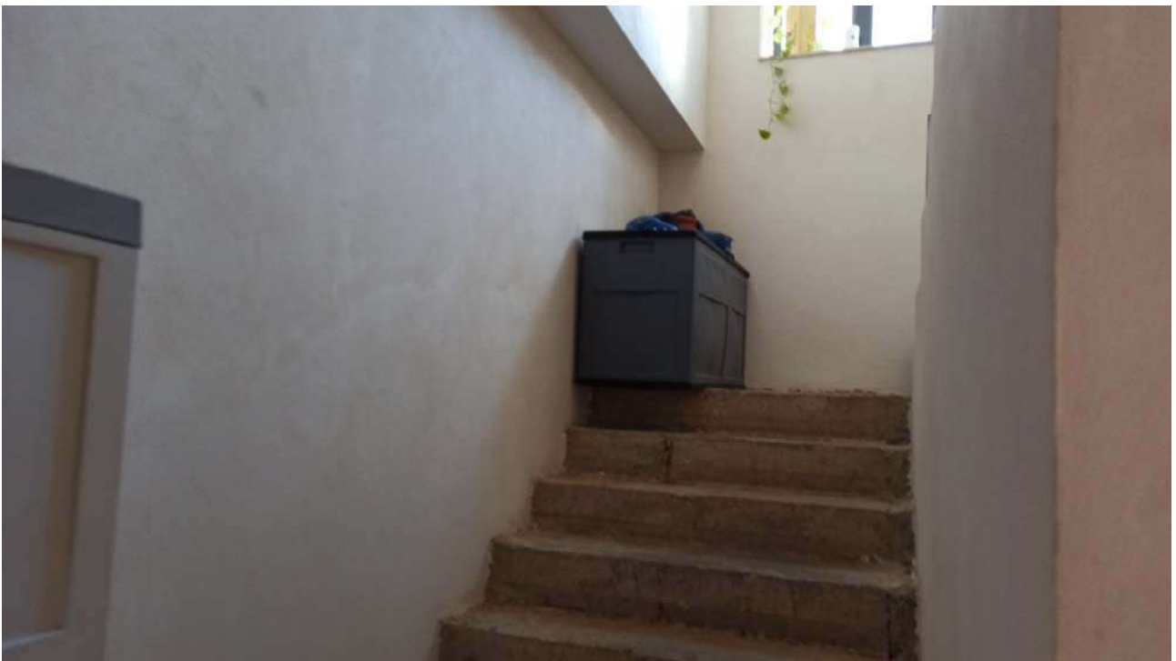
Cespite n° 1 – vano scala
