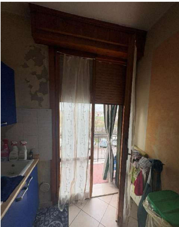
Dettaglio della portafinestra verso il balcone.
