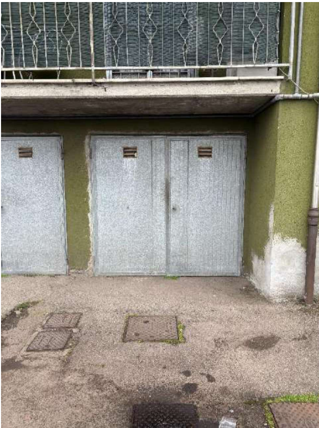
Dettaglio dell'ingresso all'autorimessa.
