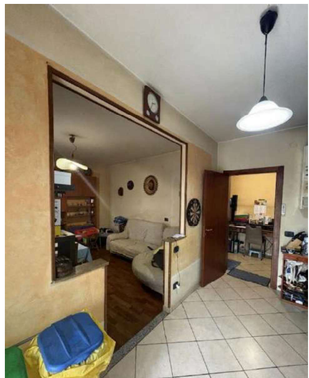
Vista dell'apertura realizzata nella tramezza tra cucina e zona giorno
