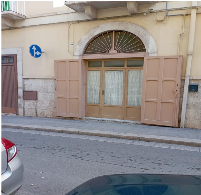
FOTO N. 4 - PORTONE INGRESSO ABITAZIONE
