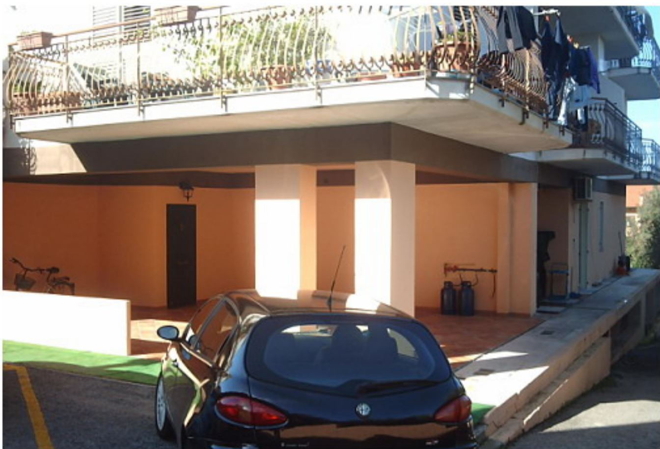
Lotto 2 - Prospetto lato Sud-Est sub 4
