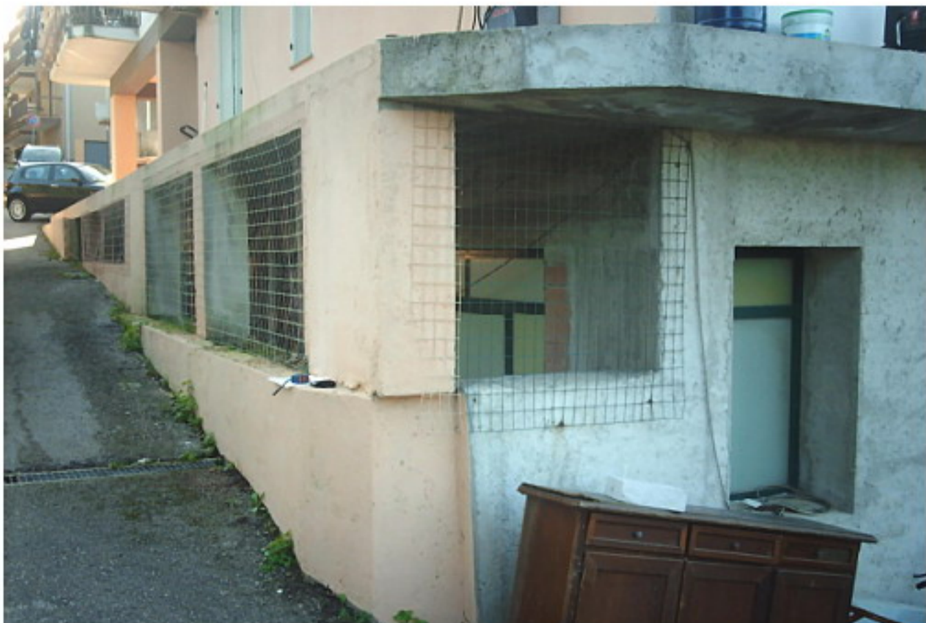
Lotto 1 - Prospetto lato Nord-Est sub 3
