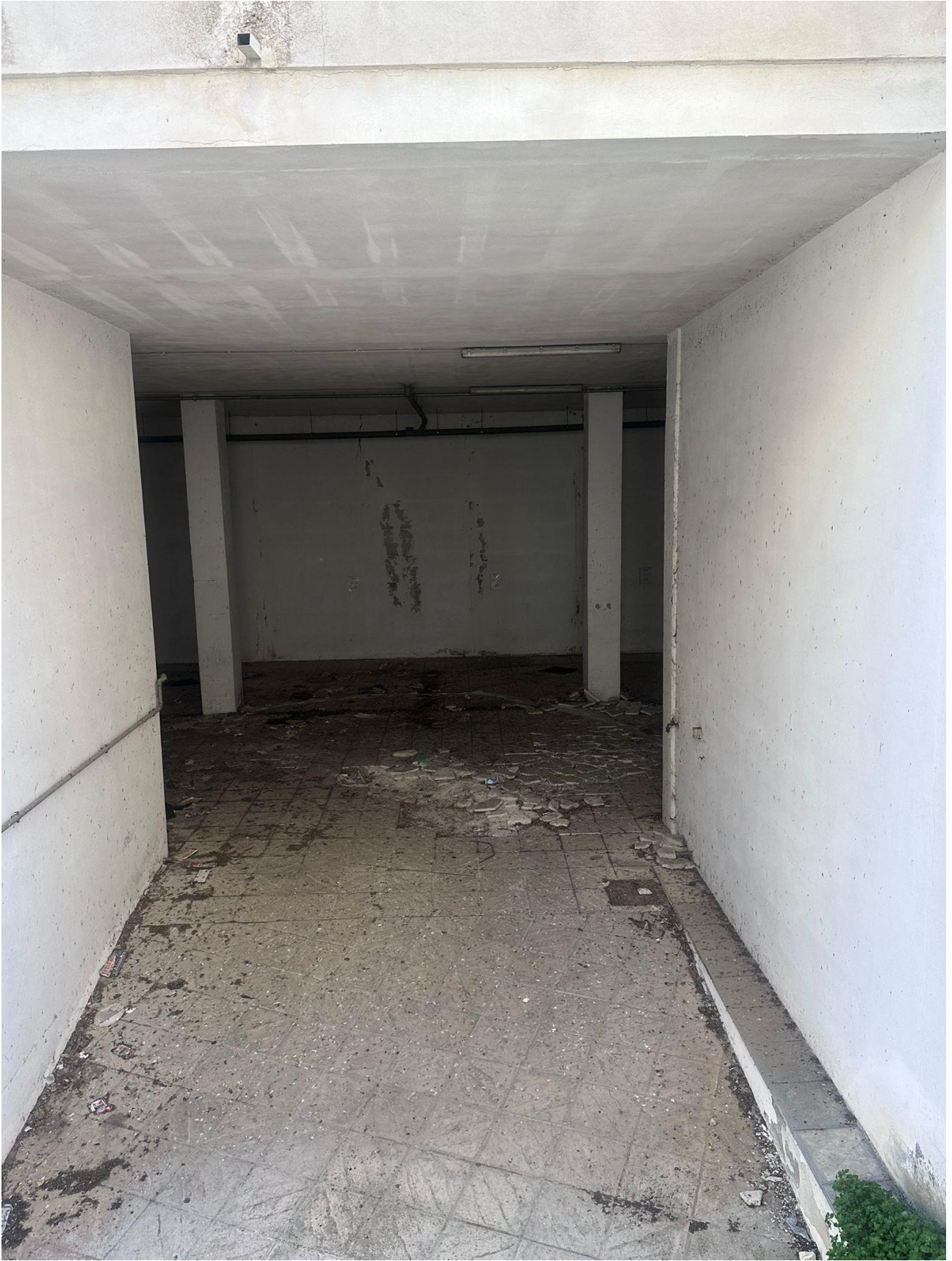
FOTO 4: VISTA INGRESSO GARAGE.
