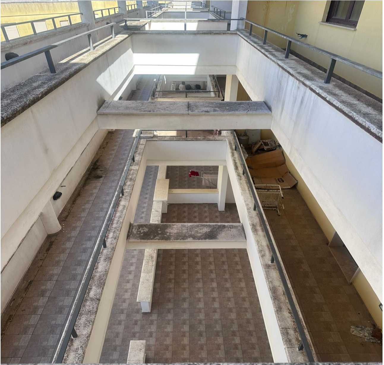
FOTO 22: VISTA SUI PIANI INFERIORI E SUI CORRIDOI INTERNI DAL TERZO PIANO
