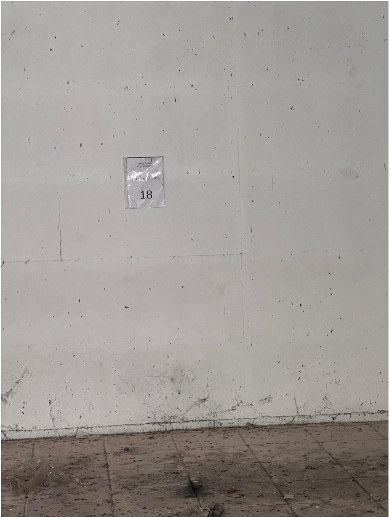
FOTO 8: POSTO AUTO N. 18 DI PROPRIETA' MAURIZIO FORTE.
