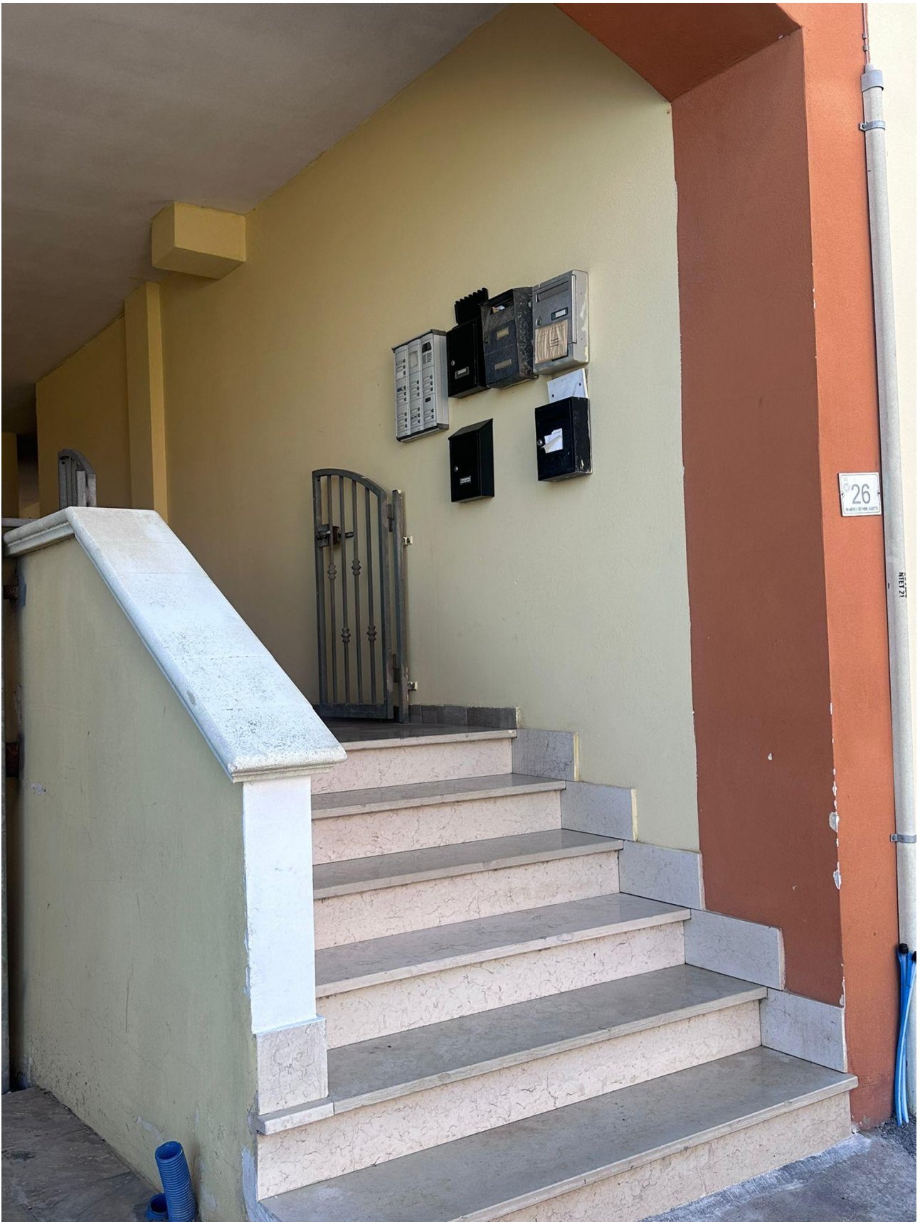
FOTO 10: INGRESSO CIVICO 26 VIA GIOVANNI MICHELE LAGGETTO IN POGGIARDO (LE)
