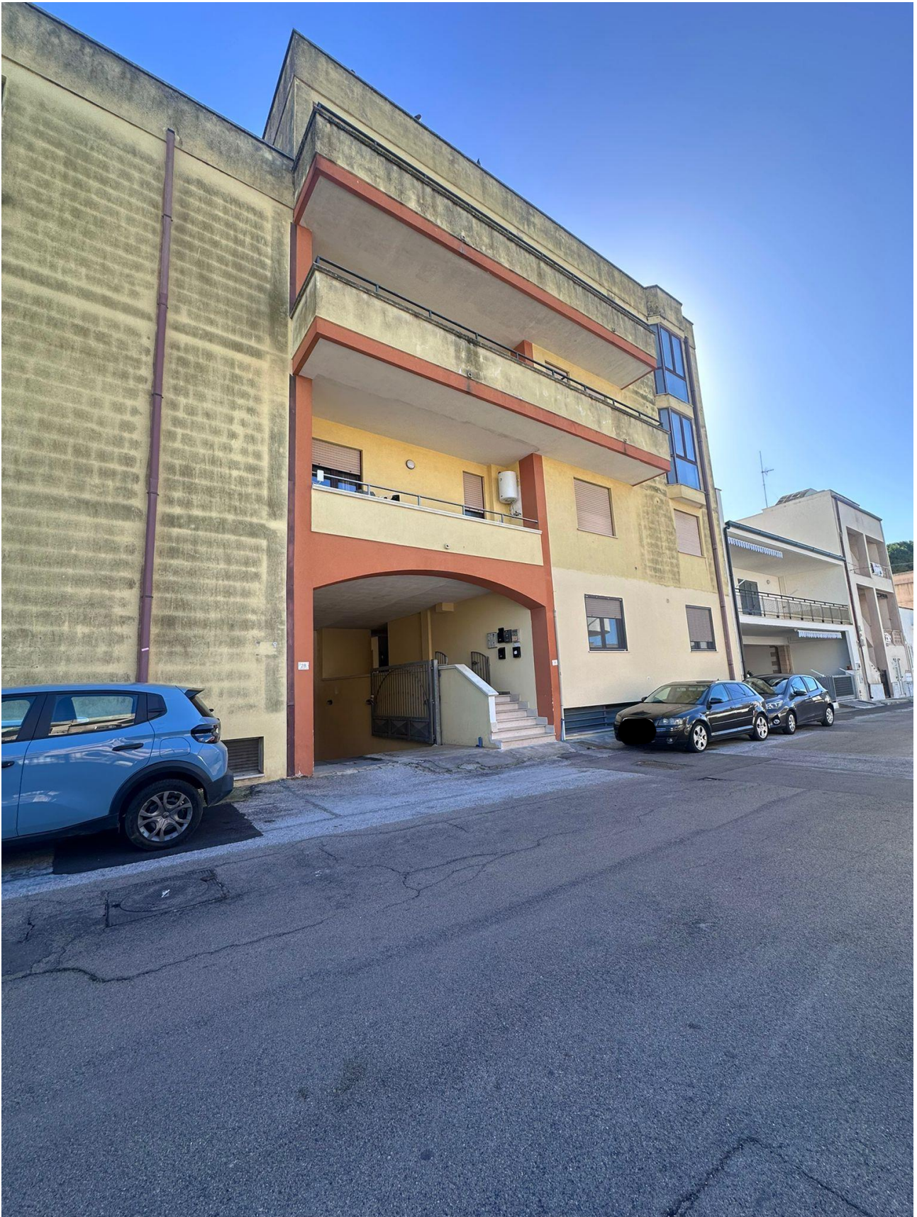
FOTO 9: INGRESSO CIVICO 26-28 VIA GIOVANNI MICHELE LAGGETTO IN POGGIARDO (LE)
