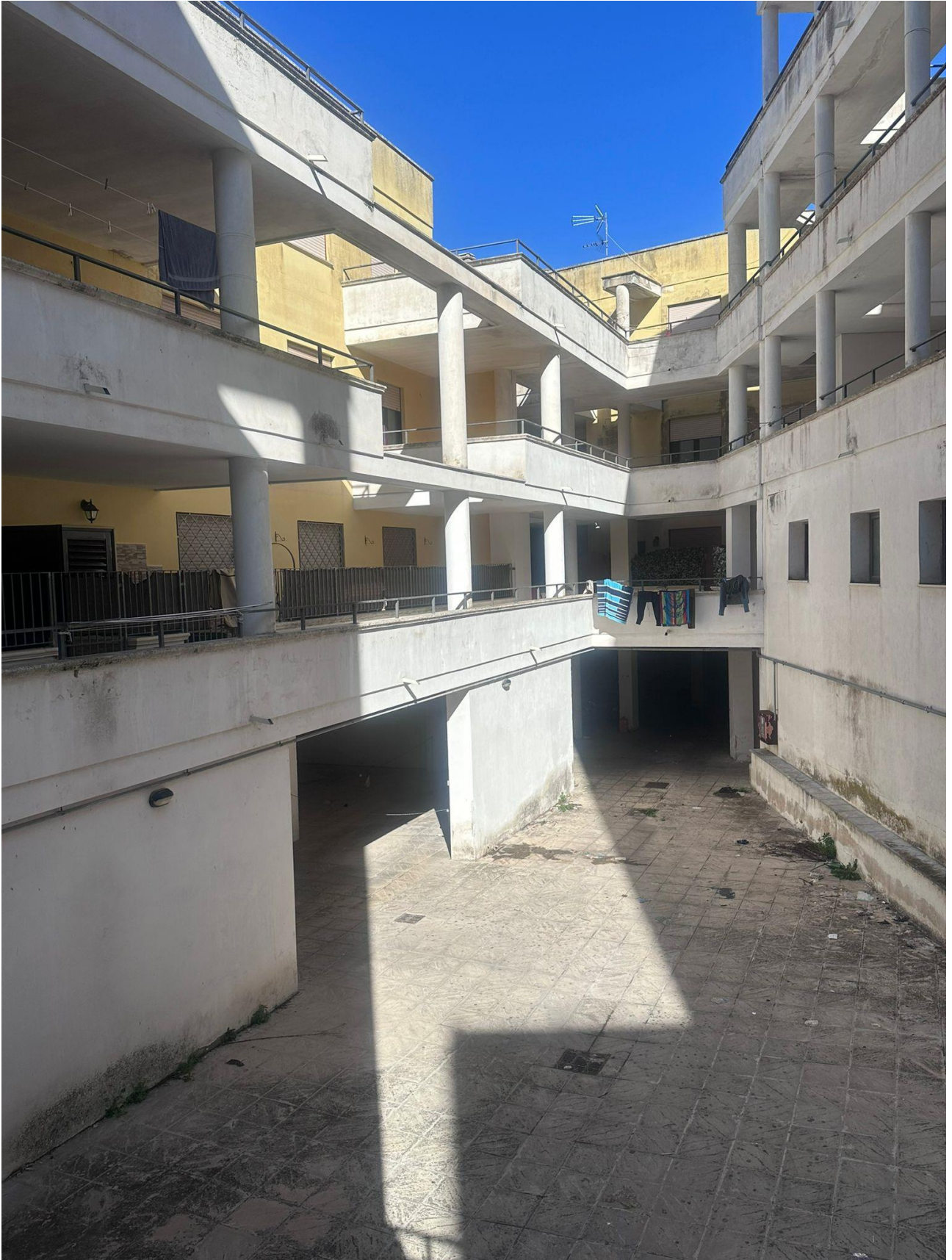
FOTO 2: VISTA DAL PIANO TERRA DELL'ANDRONE, DA CUI SI INTRAVEDONO I POSTI AUTO.
