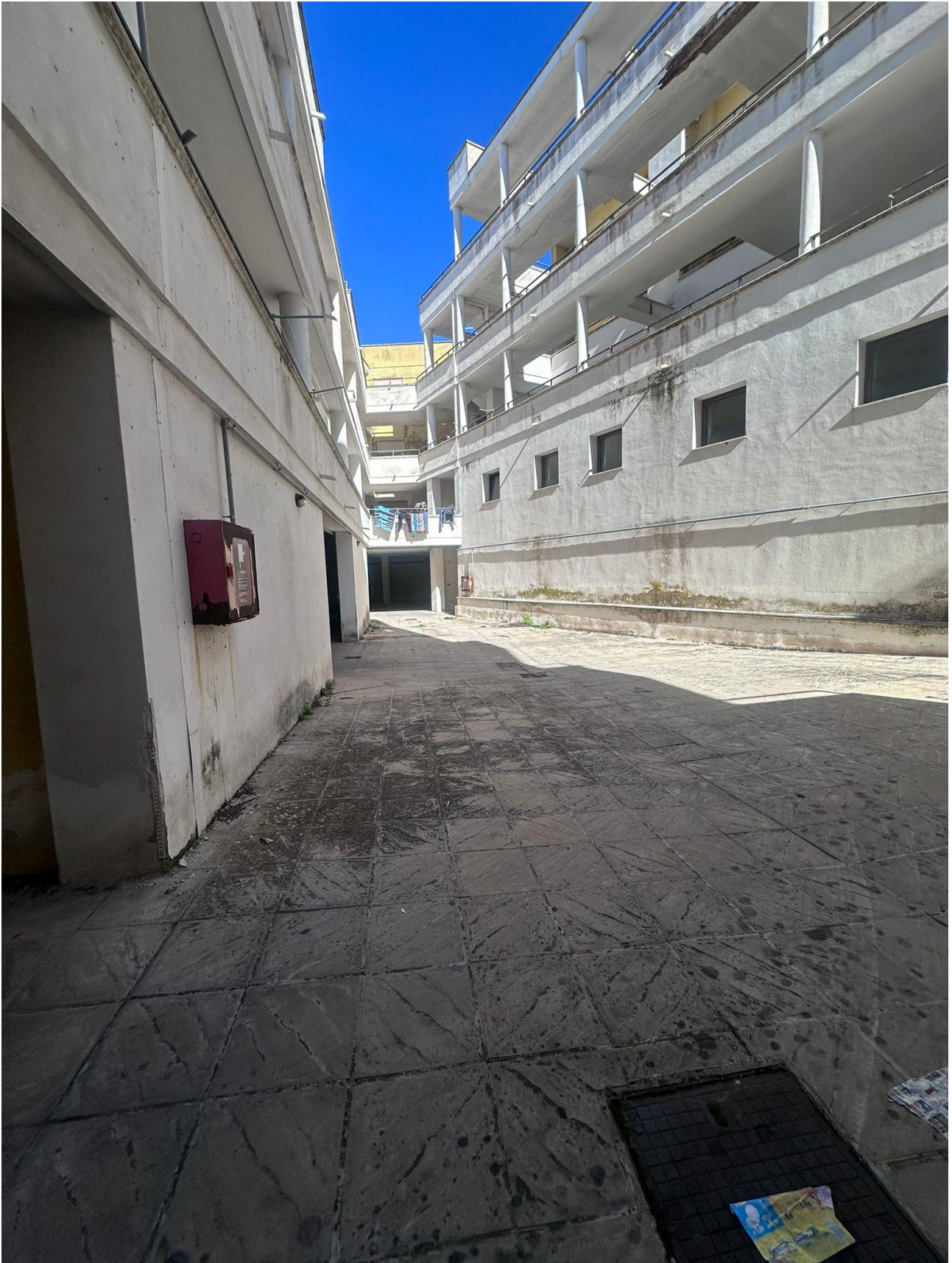
FOTO 3: ANDRONE INTERNO DI ACCESSO AI POSTI AUTO.
