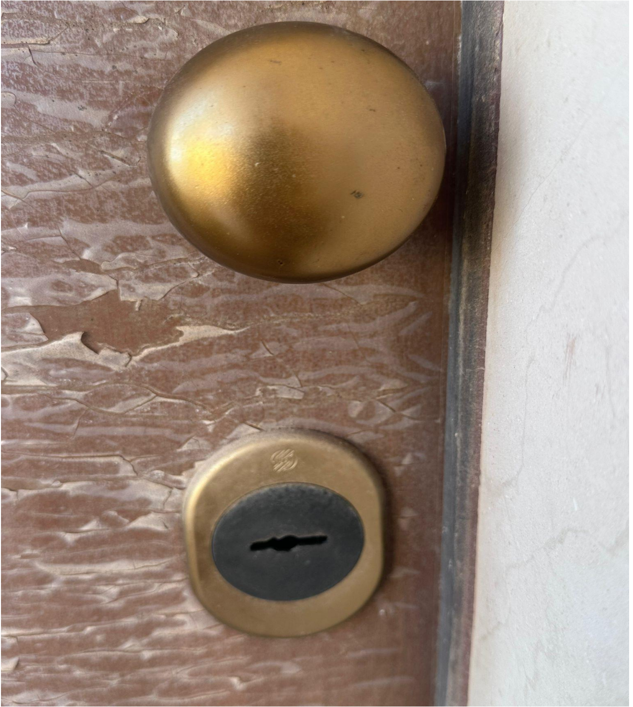
FOTO 19: SERRATURA PORTA DI INGRESSO BLINDATA.
