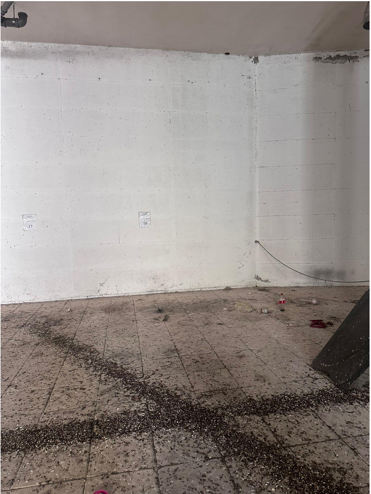
FOTO 7: VISTA POSTO AUTO N. 18 DI PROPRIETA' MAURIZIO FORTE.
