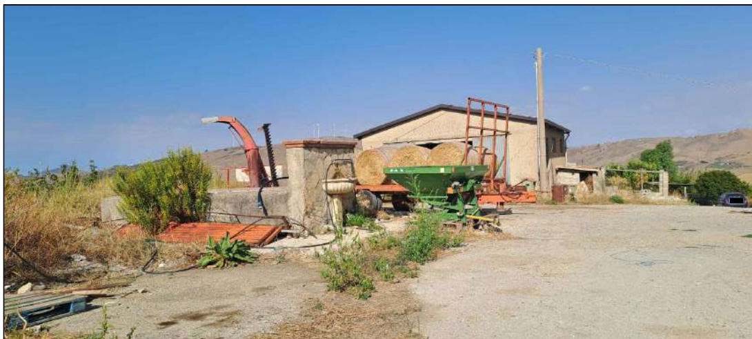
panoramica - abbeveratoio e prospetto ovest- fienile
