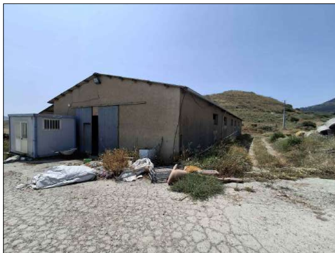
prospetto nord-ovest- stalla, vista dalla corte
