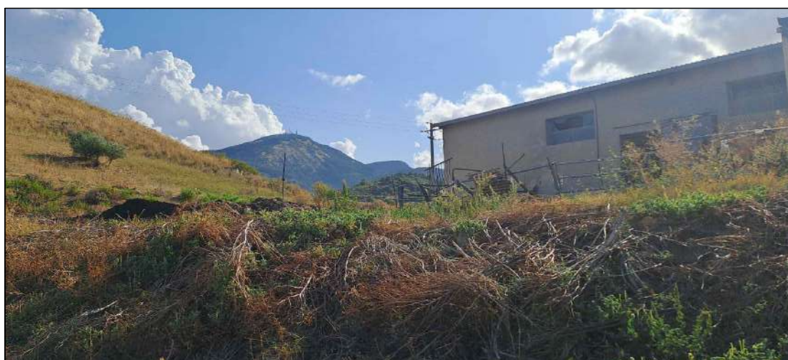
prospetto est- stalla, vista dalla strada
