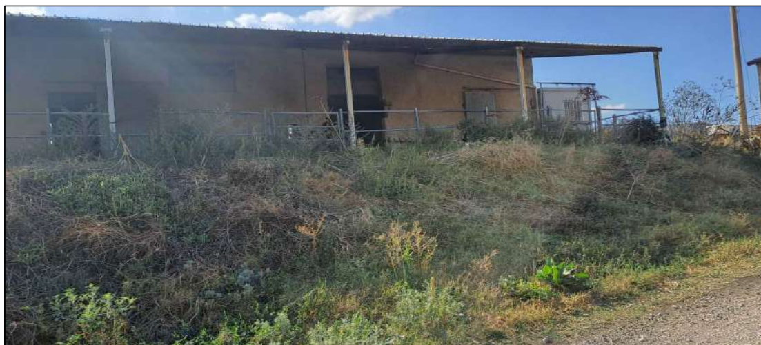
prospetto est- stalla, vista dalla strada
