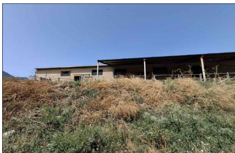
prospetto est- stalla vista dalla strada
