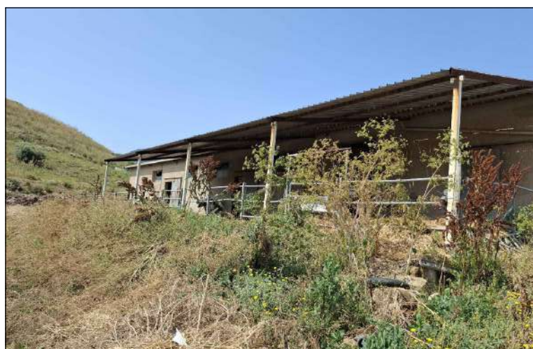
prospetto est- stalla, vista dalla strada
