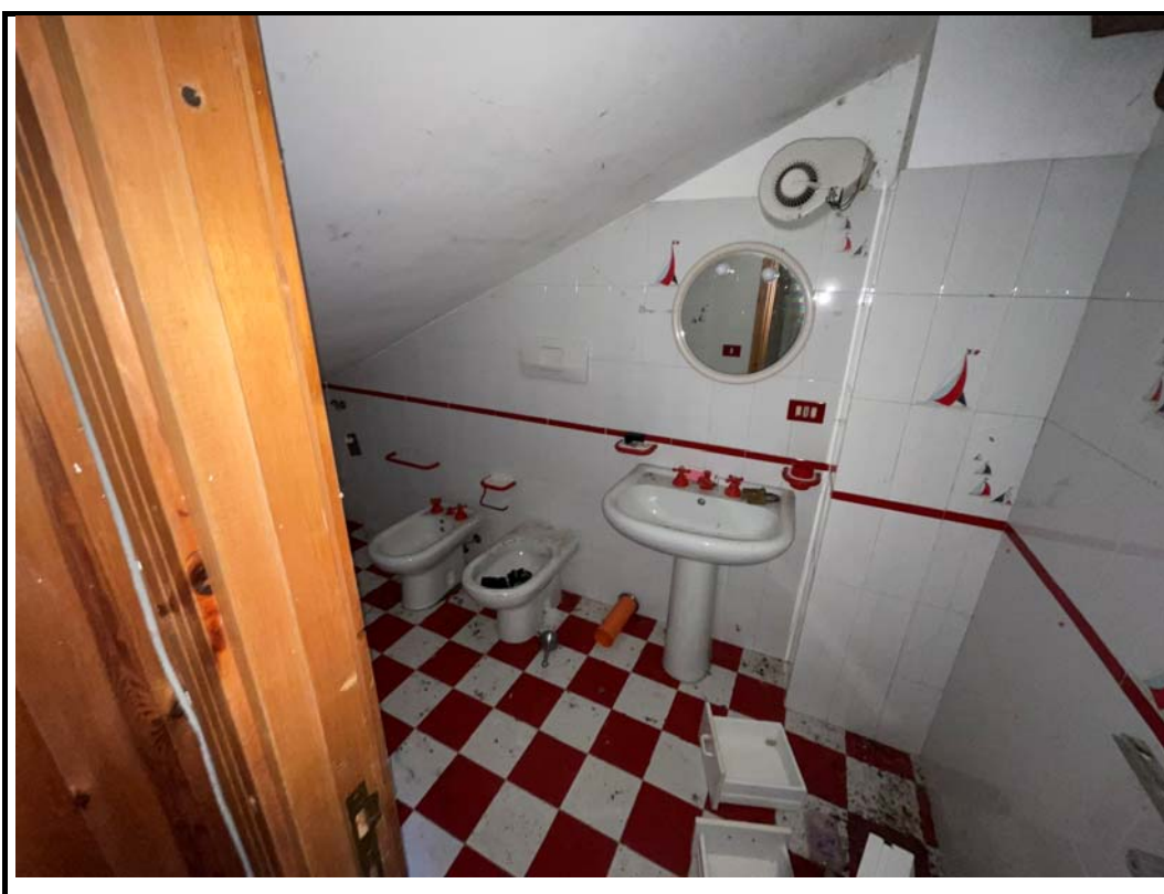
Foto 19 – particolare bagno sottotetto
