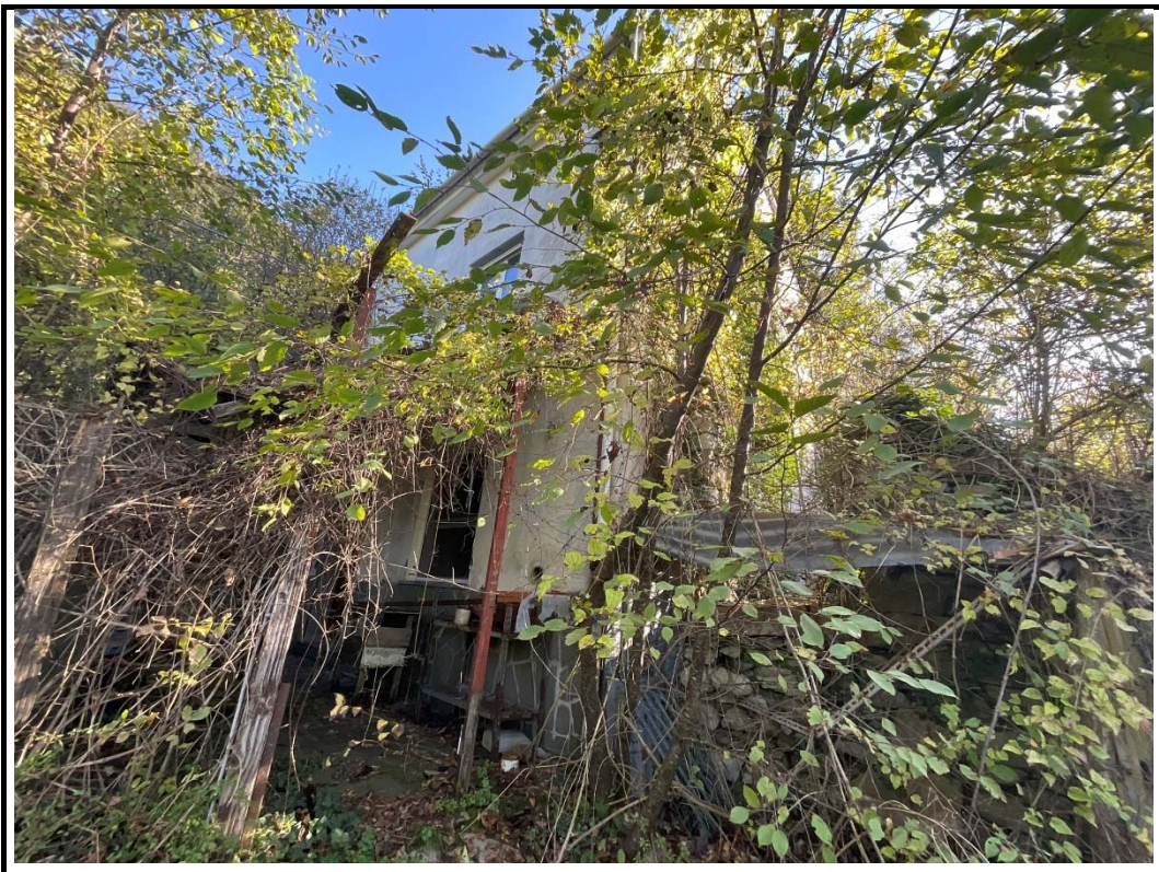
Foto 5 – particolare facciata N/O
