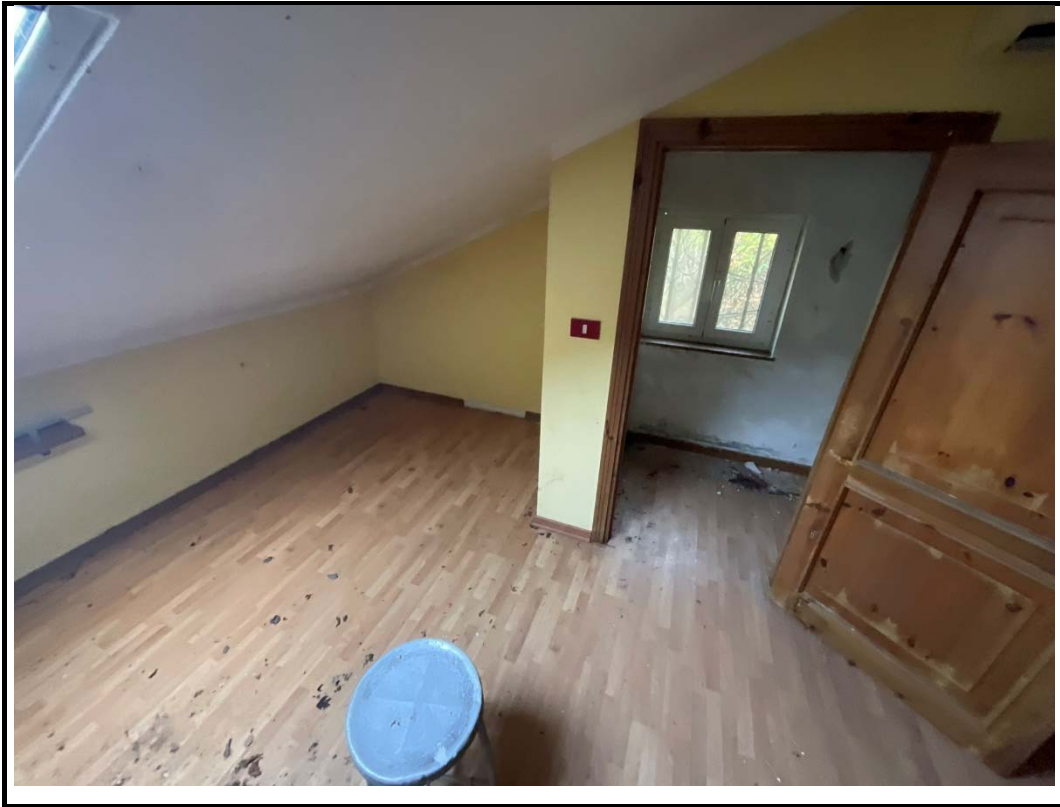
Foto 16 – particolare locale sottotetto
