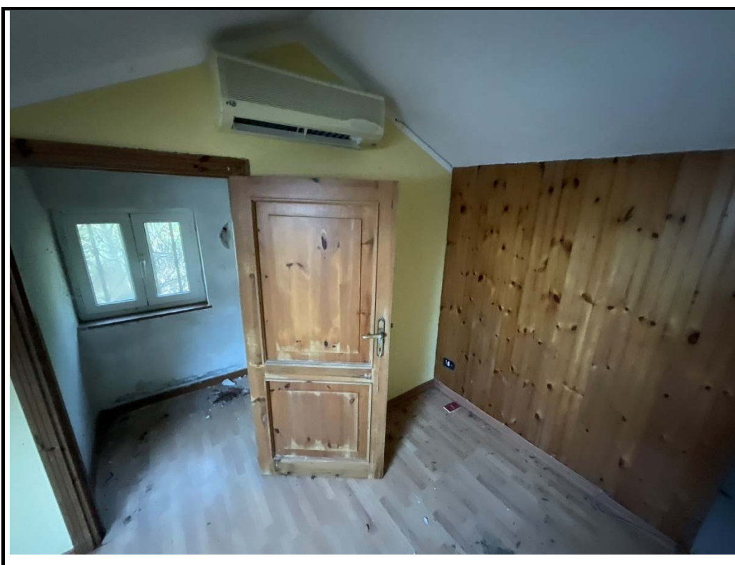
Foto 15 – particolare locale sottotetto
