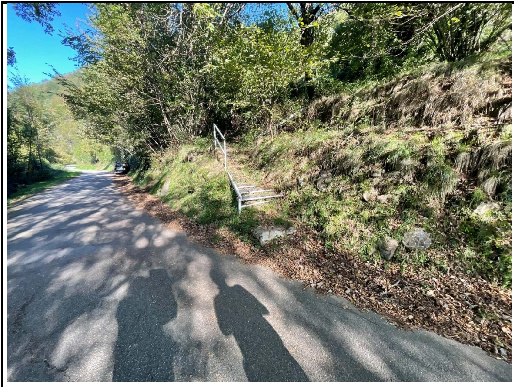
Foto 1 – Particolare accesso pedonale su via Dolo
