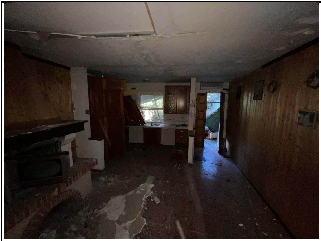
Foto 7 – particolare locale piano terra
