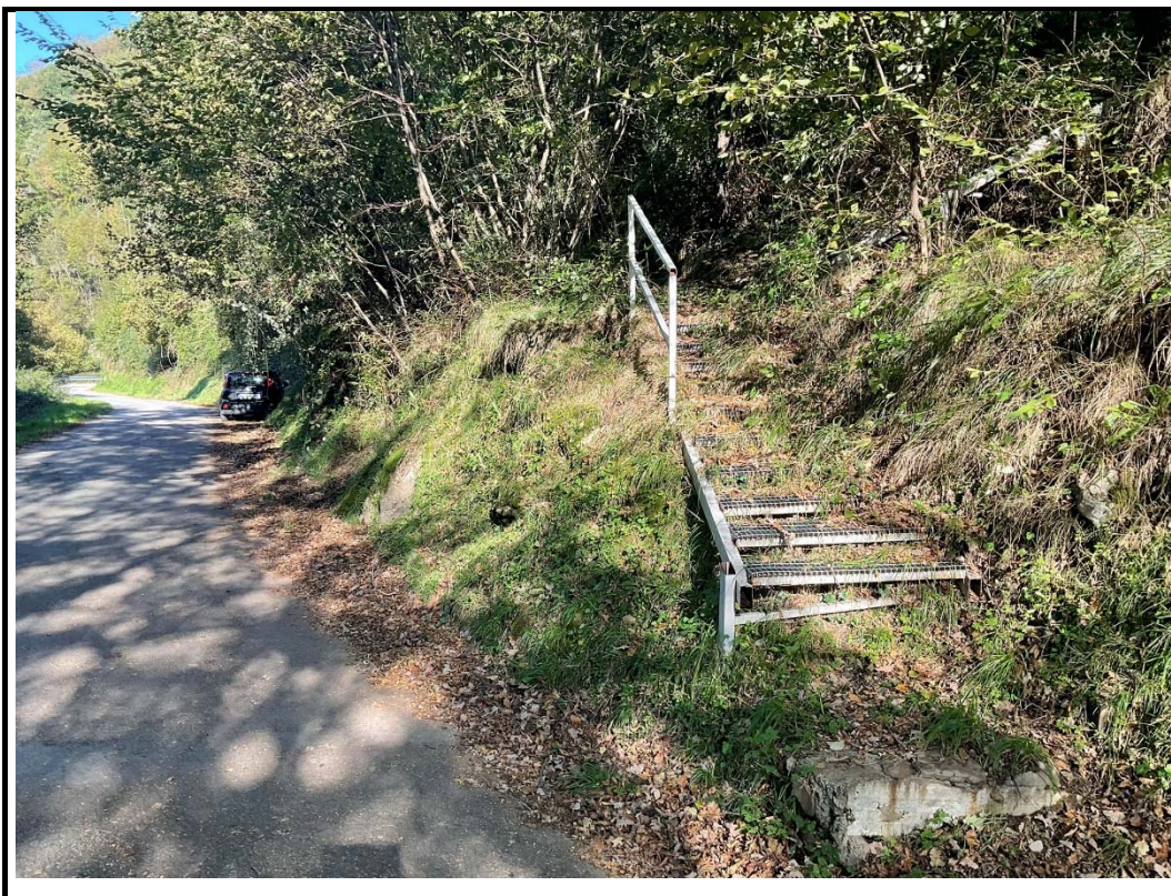
Foto 2 – Particolare accesso pedonale su via Dolo
