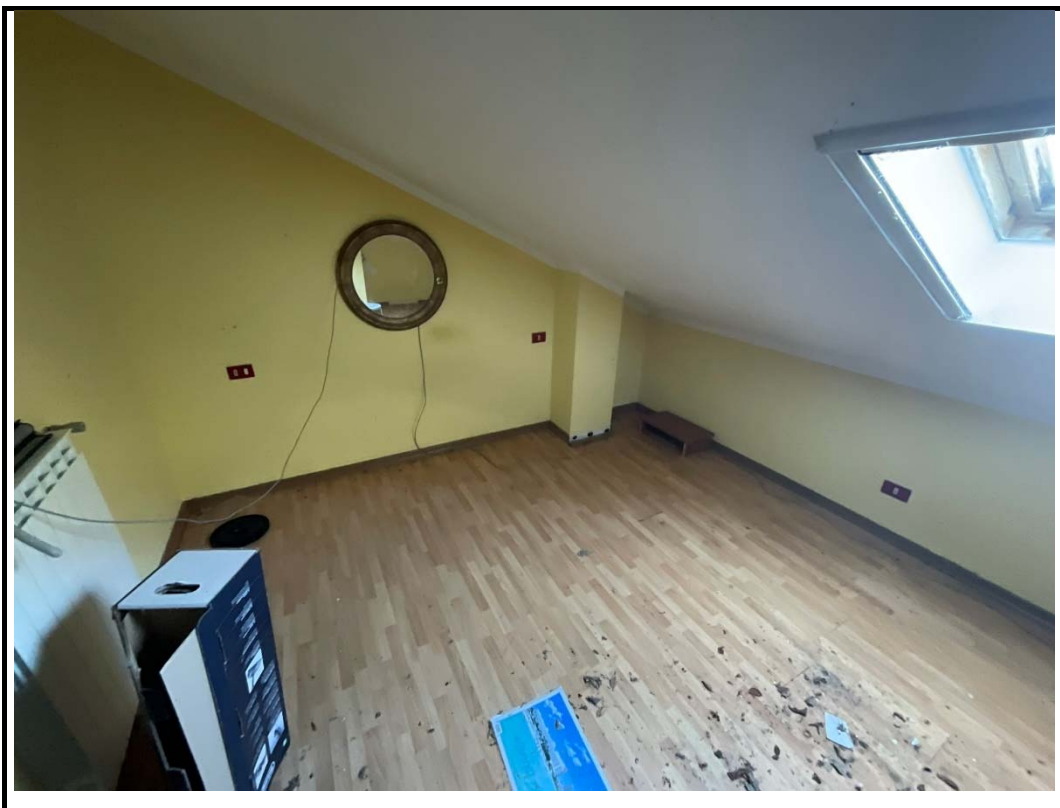
Foto 17 – particolare locale sottotetto
