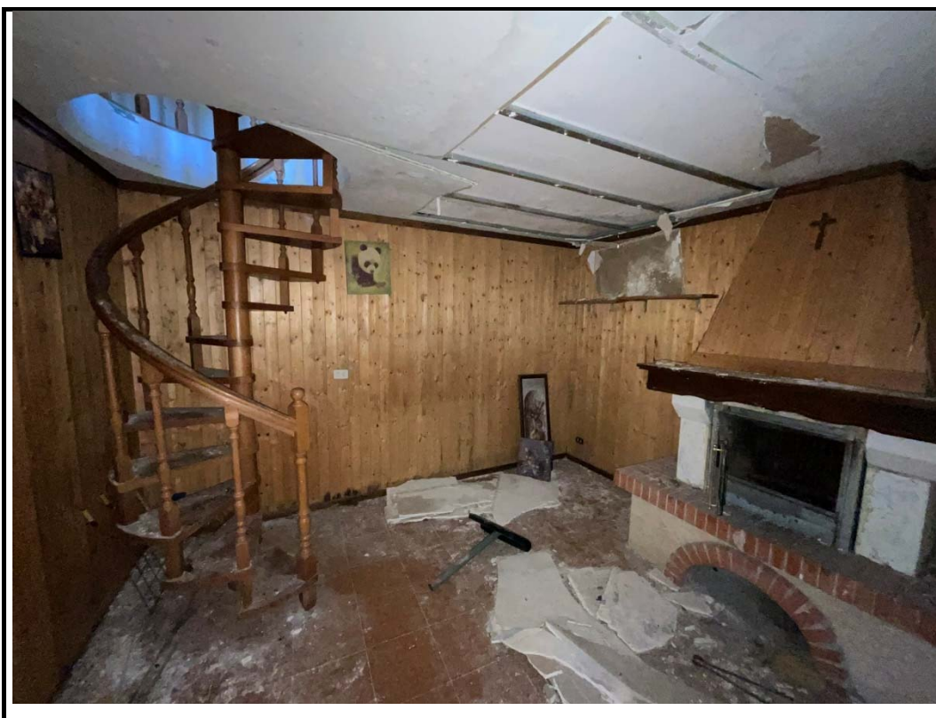
Foto 8 – particolare locale piano terra
