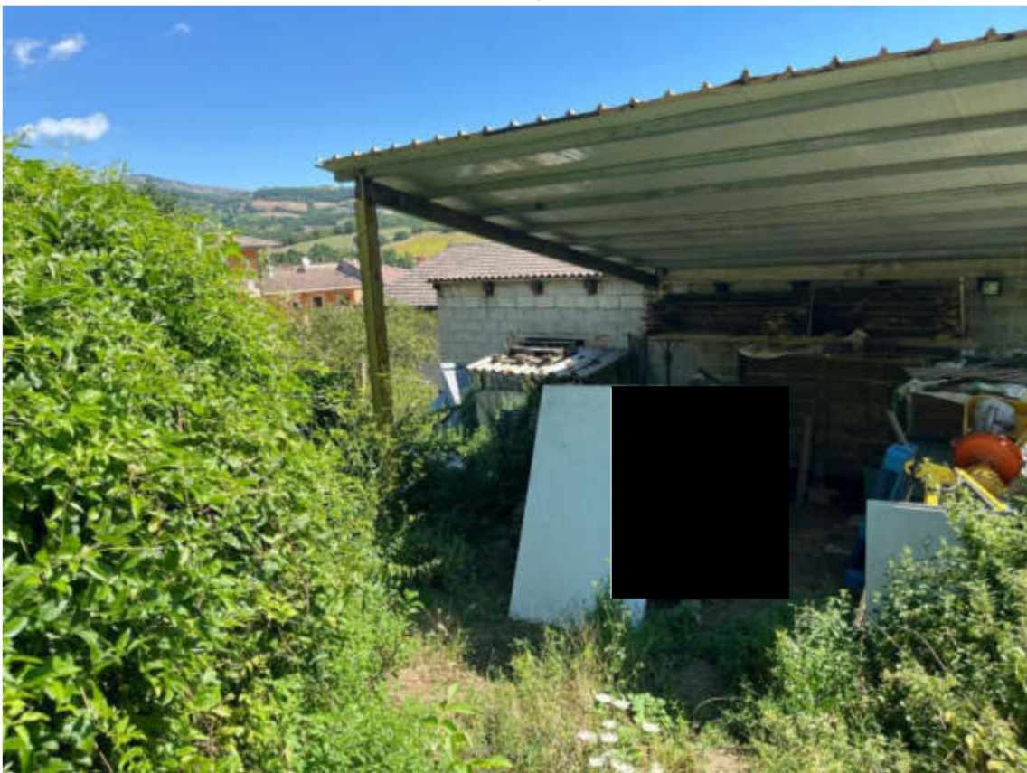
Foto 30 Tettoia posticcia C e manufatto abusivo B
