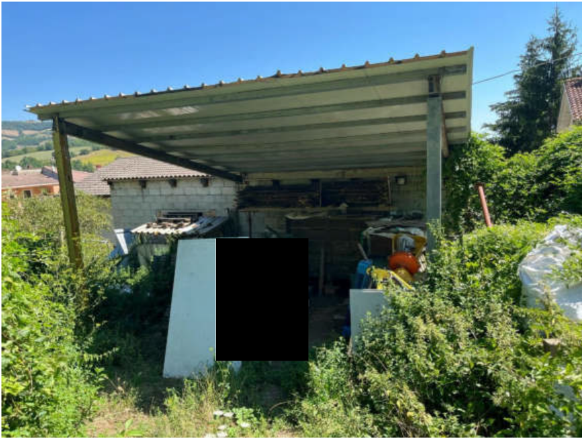
Foto 29 Tettoia posticcia C
