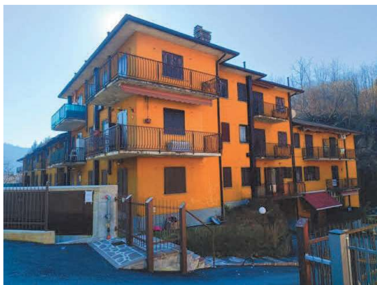
Prospetto e ingresso
